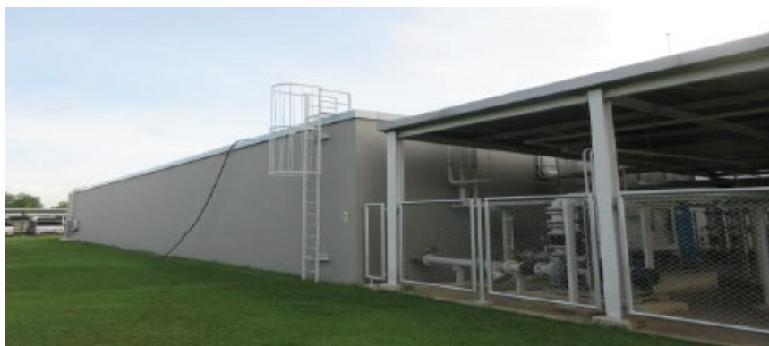
ภาพที่ 2-31 ถังเก็บน้ำดับเพลิงสำรองของโรงงาน
