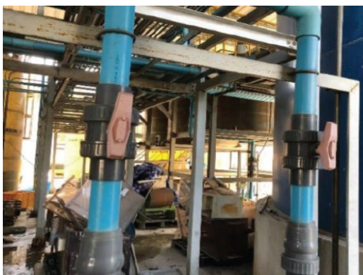
ภาพที่ 2-22 การติดตั้งวาล์วเปิด-ปิด เพื่อควบคุมการปล่อยน้ำเสียของโรงงาน
