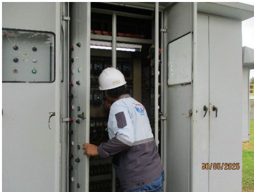
ภาพที่ 2-11 พนักงานตรวจสอบอุปกรณ์ไฟฟ้าที่ระบบบำบัดน้ำเสีย
