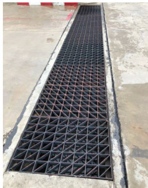
ภาพที่ 2-28 ตัวอย่างการระบายน้ำเสียและระบายน้ำฝนของโรงงาน
