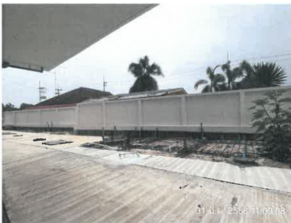
รูปที่ 2-1 แสดงการติดตั้งรั้ว Metal Sheet บริเวณพื้นที่ก่อสร้าง และการรื้อรั้ว Metal Sheet บางส่วนออก เพื่อดำเนินการก่อสร้างกำแพง
