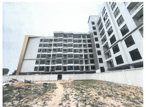
รูปที่ 2-1 แสดงการติดตั้งรั้ว Metal Sheet บริเวณพื้นที่ก่อสร้าง และการรื้อรั้ว Metal Sheet บางส่วนออก เพื่อดำเนินการก่อสร้างกำแพง
