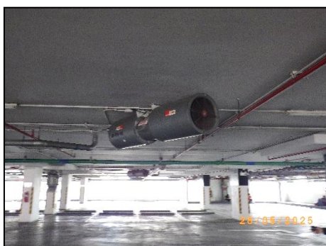
พัดลมดูดอากาศ (Exhaust Fan) ภายในอาคารจอดรถ
