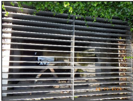
ตะแกรงครอบท่อระบายน้ำภายนอกอาคาร
