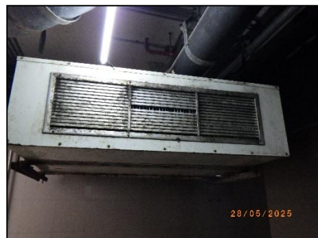
ระบบปรับอากาศภายในห้องพักมูลฝอยเปียก
