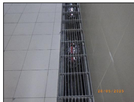
ตะแกรงครอบท่อระบายน้ำภายในอาคาร
