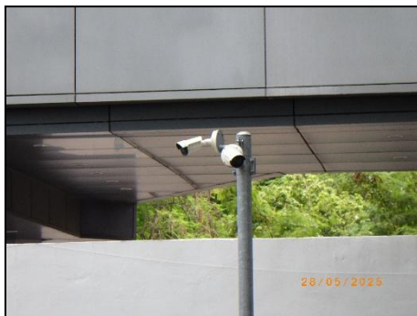
รูปที่ 2-56 การติดตั้งกล้องวงจรปิด (CCTV)
