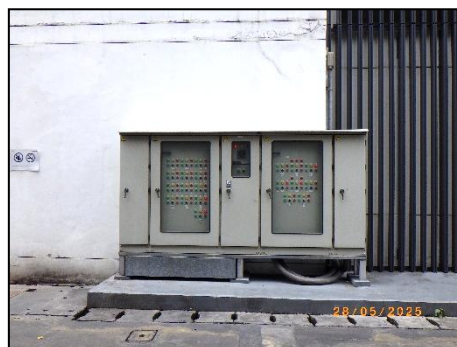
ระบบมอเตอร์ไฟฟ้าสำหรับระบบบำบัดน้ำเสีย
