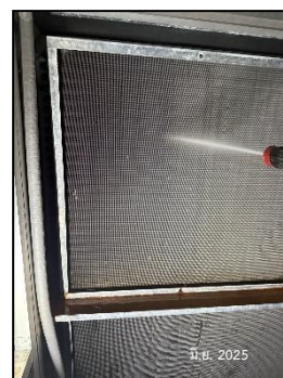
รูปที่ 2-40 การทำความสะอาดเครื่องปรับอากาศ
