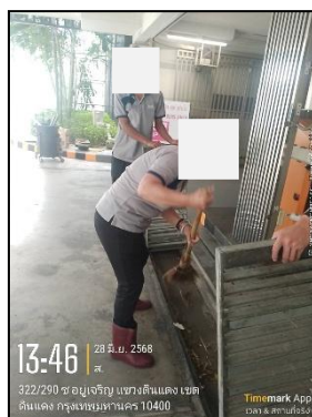
รูปที่ 2-15 การทำความสะอาดและลอกท่อระบายน้ำ
