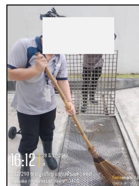
รูปที่ 2-15 การทำความสะอาดและลอกท่อระบายน้ำ
