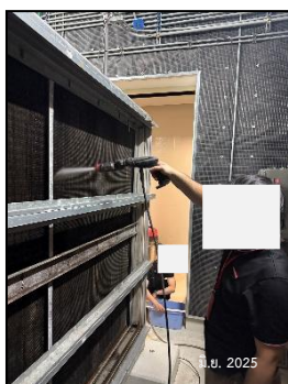
รูปที่ 2-40 การทำความสะอาดเครื่องปรับอากาศ
