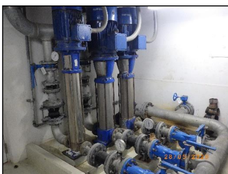
ระบบสูบน้ำรีไซเคิล
