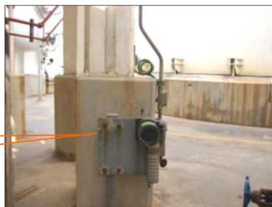
Gas Detector บริเวณที่เก็บสารเคมี
