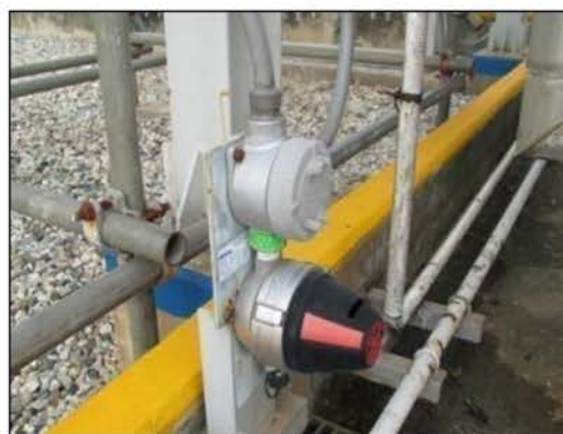
ภาพที่ 2.1-8 อุปกรณ์ตรวจสอบความปลอดภัย เช่น Gas Detector, Smoke Detector
