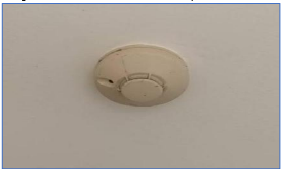
เครื่องตรวจจับควัน (SMOKE DETECTOR) เครื่องตรวจจับความร้อน (HEAT DETECTOR)
