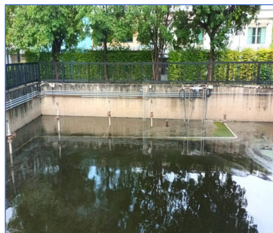
บ่อพักน้ำสุดท้ายก่อนระบายออกนอกโครงการ พร้อมเครื่องเติมอากาศ
