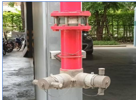
หัวรับน้ำดับเพลิง ด้านหน้าอาคารชุดพักอาศัย
