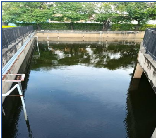
บ่อพักน้ำสุดท้ายก่อนระบายออกนอกโครงการ พร้อมเครื่องเติมอากาศ
