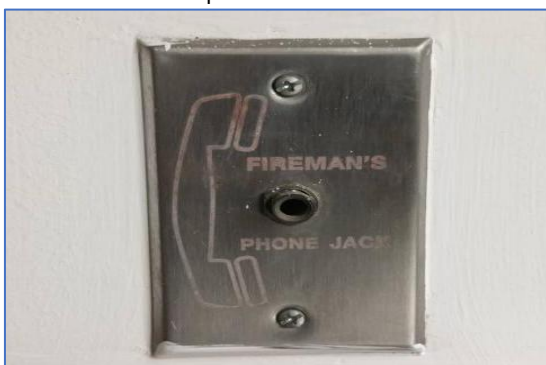
โทรศัพท์ฉุกเฉิน (Telephone Jack)
