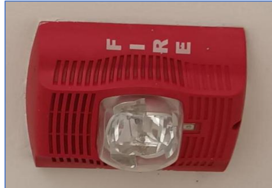
เครื่องแจ้งเหตุโดยใช่มือดึง (Manual Station) กริ่งสัญญาณเตือนภัย (Fire Alarm Speaker)
