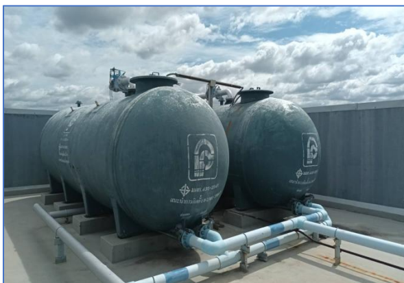
ถังเก็บน้ำ ชั้นดาดฟ้า พร้อมเครื่องปั๊มน้ำ
