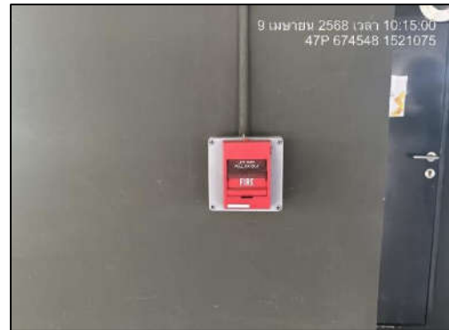
รูปที่ 30 ชุดกดแจ้งเหตุแบบใช้มือ (Manual station)
