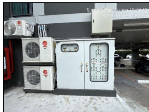
รูปที่ 11 ระบบมิเตอร์ไฟฟ้าระบบบำบัดน้ำเสีย
