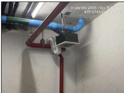
รูปที่ 19 พัดลมดูดอากาศห้องพักมูลฝอยรวม
