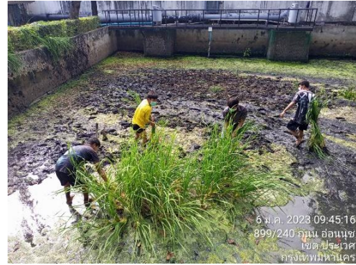
ภาพที่ 2-6 การลอกคลองบ่อหนองน้ำบริเวณระบบบำบัดน้ำเสีย
