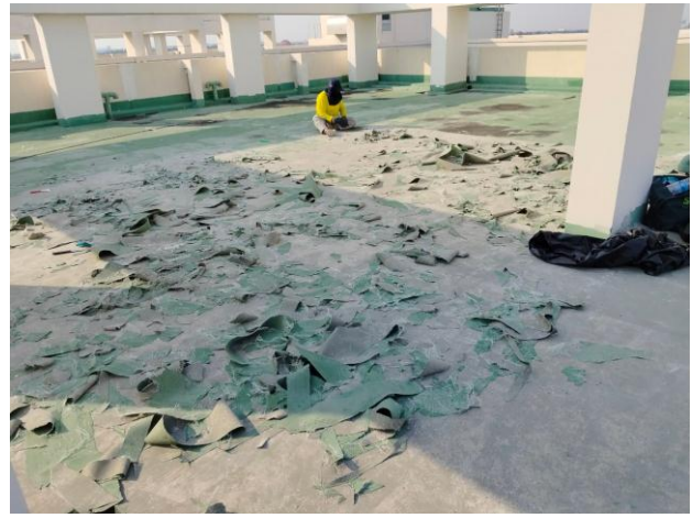
ผู้รับเหมา ดำเนินการทำกันซึมชั้นดาดฟ้า อาคาร B
