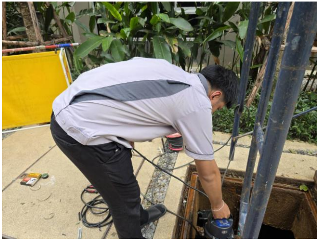
ช่างอาคารฯ ดำเนินการติดตั้งปั้มน้ำบำบัดอาคาร C ที่น้ำส่งซ่อม
