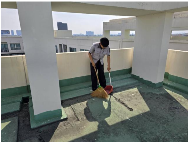
ช่างอาคารฯ ดำเนินการตรวจสอบและทำความสะอาดรางระบายน้ำดาดฟ้า อาคาร A B และ C (ตามแผนงาน)
