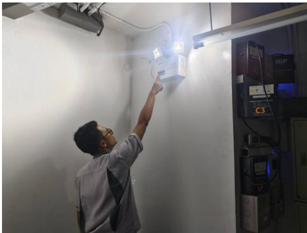
ช่างอาคารฯ ดำเนินการตรวจเช็คระบบไฟฉุกเฉิน (Emergency light) (ตามแผนงาน)
