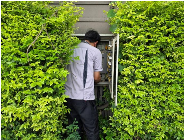
ช่างอาคารฯ ตรวจสอบเช็คระบบเดรนปั๊มป้องกันน้ำท่วม (ตามแผนงาน)
