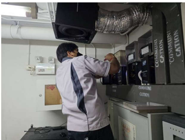
ช่างอาคารฯ ดำเนินการเปลี่ยนแบตเตอรี่ระบบแจ้งเตือนเหตุเพลิงไหม้ และระบบประตูคีย์การ์ด อาคาร A B และอาคาร C
