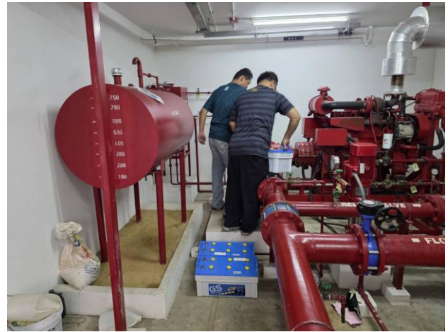
ผู้รับเหมา เข้าดำเนินการเปลี่ยนแบตเตอรี่ปั๊มน้ำดับเพลิง
