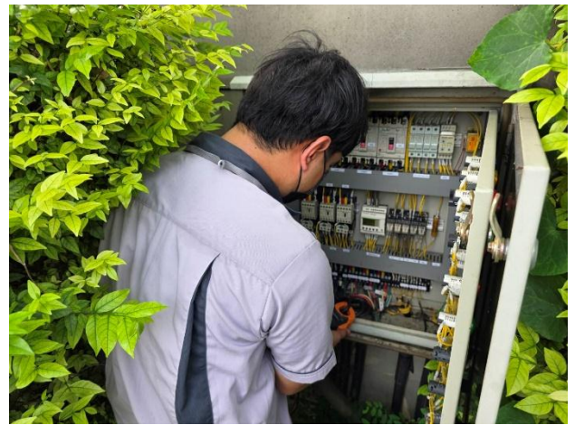
ช่างอาคารฯ ตรวจสอบเช็คระบบเดรนปั๊มป้องกันน้ำท่วมอาคาร (ตามแผนงาน)
