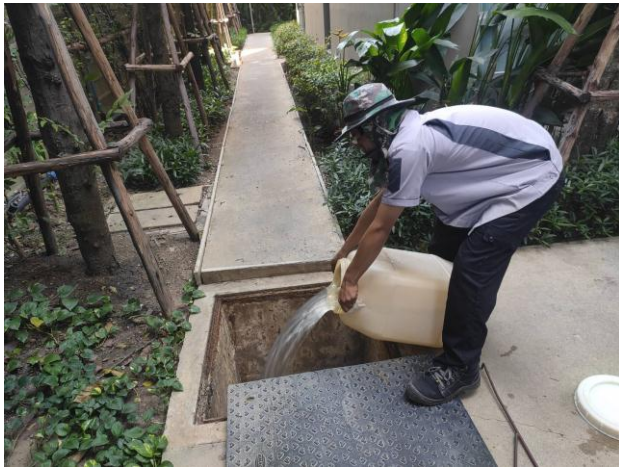
ช่างอาคารฯ เติมจุลินทรีย์ บริเวณบ่อบำบัดน้ำเสีย อาคาร A B และอาคาร C
