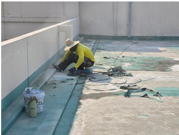
ผู้รับเหมา ดำเนินการทำกันซึมชั้นดาดฟ้า อาคาร A
