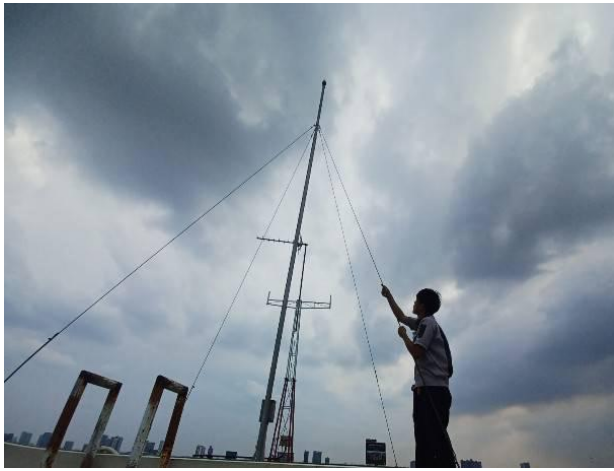
ช่างอาคารฯ ดำเนินการตรวจสอบเสาอากาศ ระบบ MATV อาคาร A B และอาคาร C (ตามแผนงาน)
