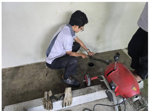
ช่างอาคารฯ ดำเนินการแก้ไขท่อน้ำบริเวณใต้อาคาร A เนื่องจากท่อน้ำอุดตัน
