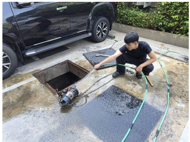
ช่างอาคารฯ ดำเนินการตรวจเช็คปั้มน้ำสูบน้ำกลับ อาคาร A เนื่องจากไม่สามารถเปิดใช้งานปั้มน้ำได้
