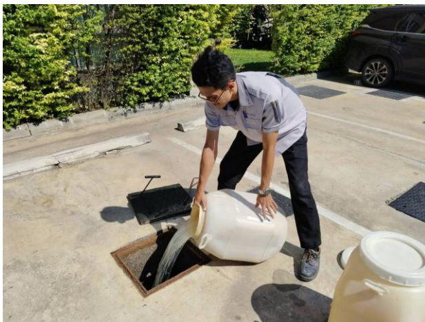
ช่างอาคารฯ เติมจุลินทรีย์ บริเวณบ่อบำบัดน้ำเสีย อาคาร A B และอาคาร C
