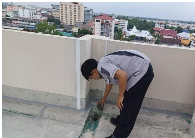
ช่างอาคารฯ ดำเนินการตรวจสอบและทำความสะอาดรางระบายน้ำดาดฟ้า อาคาร A B และ C (ตามแผนงาน)
