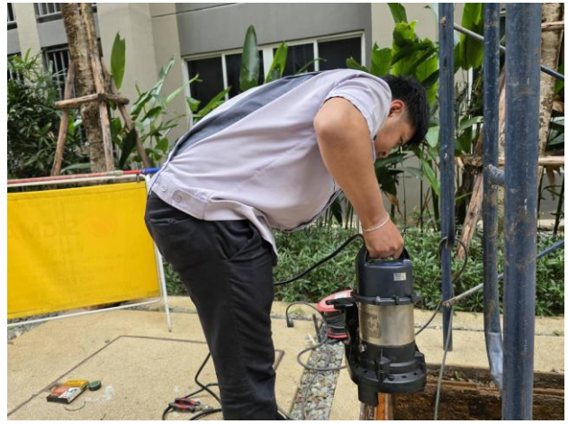
ช่างอาคารฯ ดำเนินการติดตั้งปั้มน้ำบำบัดอาคาร C ที่น้ำส่งซ่อม
