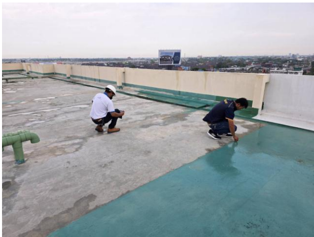
เจ้าหน้าที่จากบริษัท TOA และบริษัท MEE เข้าตรวจสอบความเรียบร้อยงานทำกันซึมชั้นดาดฟ้า
