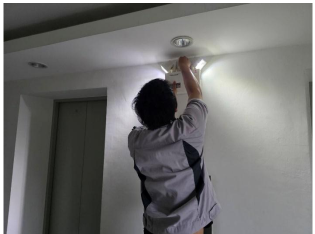
ช่างอาคารฯ ดำเนินการเปลี่ยนแบตเตอรี่ไฟฉุกเฉิน (Emergency light)
