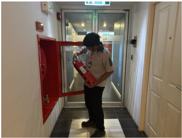
ช่างอาคารฯ ตรวจสอบสอบถังดับเพลิง (ตามแผนงาน)
