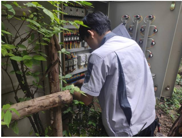
ช่างอาคารฯ ตรวจสอบระบบบ่อบำบัดน้ำเสีย (ตามแผนงานประจำเดือน)
