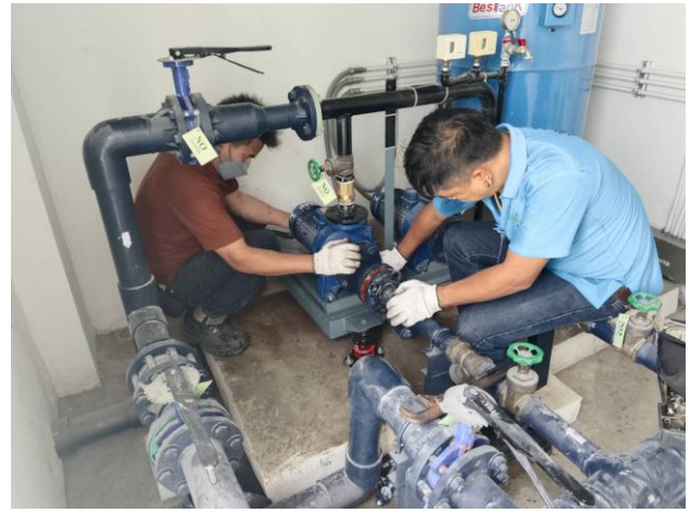
ช่างบริษัทไอริช เข้าดำเนินการเปลี่ยนตัวเซ็นควาล์วปั๊มเพิ่มแรงดันน้ำ อาคาร C
