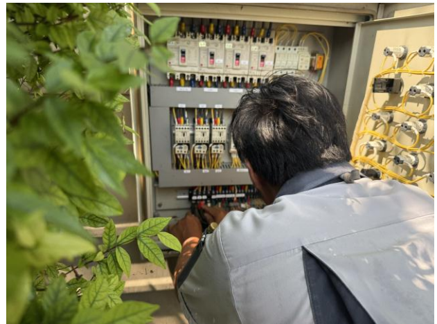
ช่างอาคารฯ ตรวจสอบระบบเดรนปั๊มป้องกันวงท่ายโครงการ (ตามแผนงาน)
