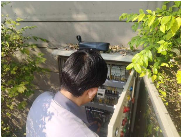
ช่างอาคารฯ ตรวจสอบระบบเดรนปั๊มบ่อบำบัดน้ำเสีย (ตามแผนงาน)
