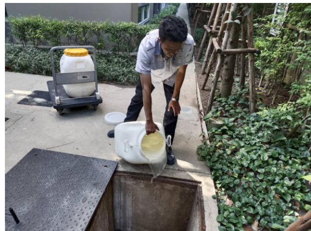
ช่างอาคารฯ เติมจุลินทรีย์ บริเวณบ่อบำบัดน้ำเสีย อาคาร A B และอาคาร C
