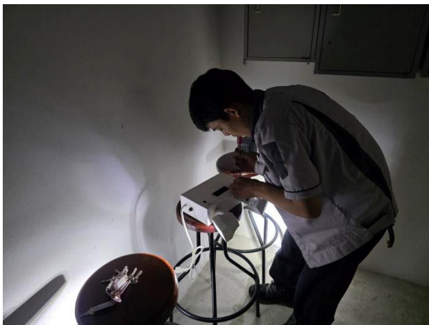
ช่างอาคารฯ ดำเนินการเปลี่ยนแบตเตอรี่ไฟฉุกเฉิน (Emergency light)
