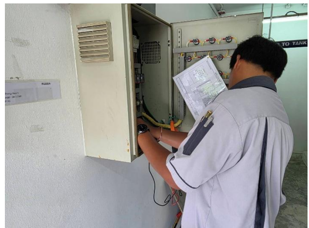
ช่างอาคารฯ ตรวจสอบเช็คระบบ Transfer pump อาคาร A B และอาคาร C (ตามแผนงาน)
