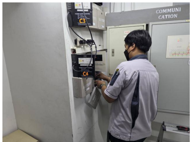
ช่างอาคารฯ ดำเนินการเปลี่ยนแบตเตอรี่ระบบแจ้งเตือนเหตุเพลิงไหม้ และระบบประตูคีย์การ์ด อาคาร A B และอาคาร C
