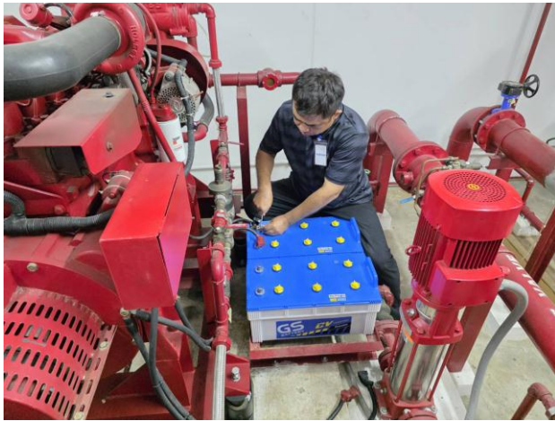
ผู้รับเหมา เข้าดำเนินการเปลี่ยนแบตเตอรี่ปั๊มน้ำดับเพลิง
