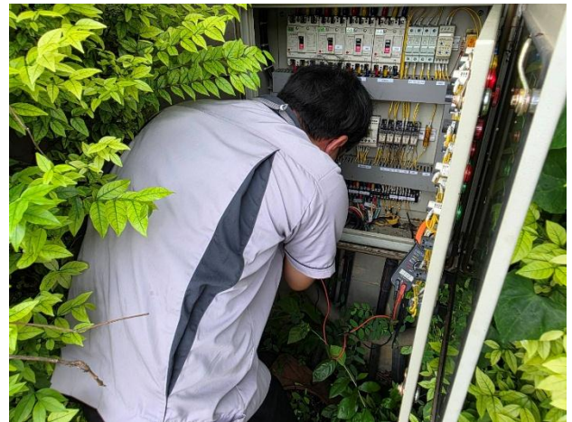
ช่างอาคารฯ ตรวจสอบเช็คระบบเดรนปั๊มป้องกันน้ำท่วม (ตามแผนงาน)
