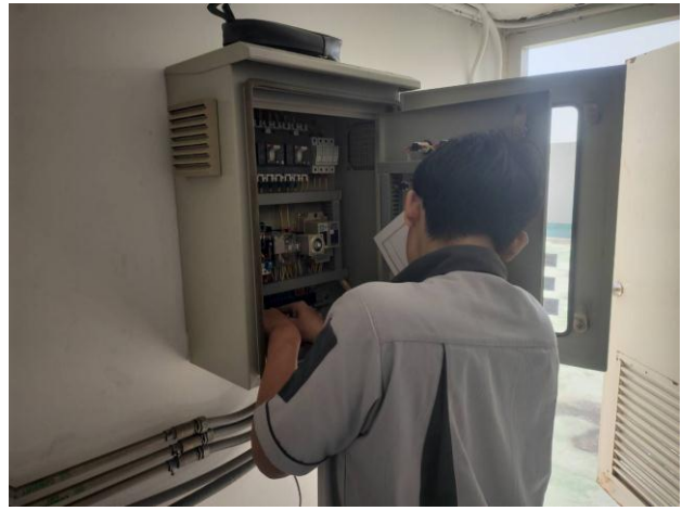
ช่างอาคารฯ ตรวจสอบใช้ระบบ Booster pump อาคาร A B และอาคาร C (ตามแผนงาน)
