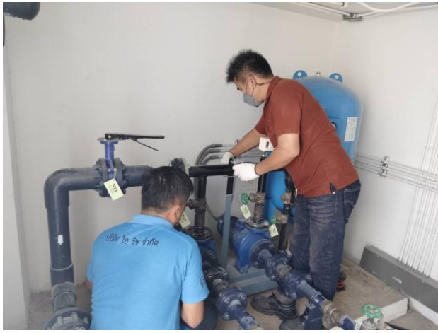
ช่างบริษัทไอริช เข้าดำเนินการเปลี่ยนตัวเซ็นควาล์วปั๊มเพิ่มแรงดันน้ำ อาคาร C
