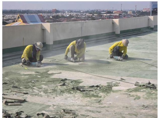
ผู้รับเหมา ดำเนินการทำกันซึมชั้นดาดฟ้า อาคาร C
