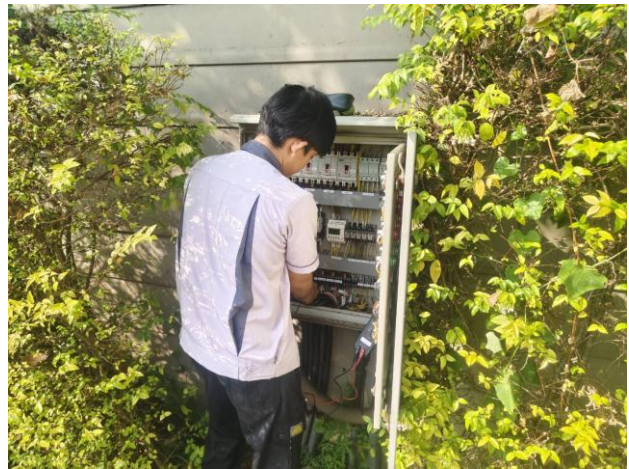
ช่างอาคารฯ ตรวจสอบระบบเดรนปั๊มบ่อบำบัดน้ำเสีย (ตามแผนงาน)
