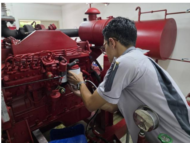
ช่างอาคารฯ ดำเนินการเปลี่ยนน้ำมันเครื่องระบบปั้มน้ำดับเพลิง
