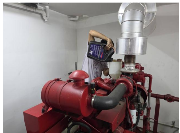
ช่างอาคารฯ ดำเนินการเปลี่ยนน้ำมันเครื่องระบบปั้มน้ำดับเพลิง
