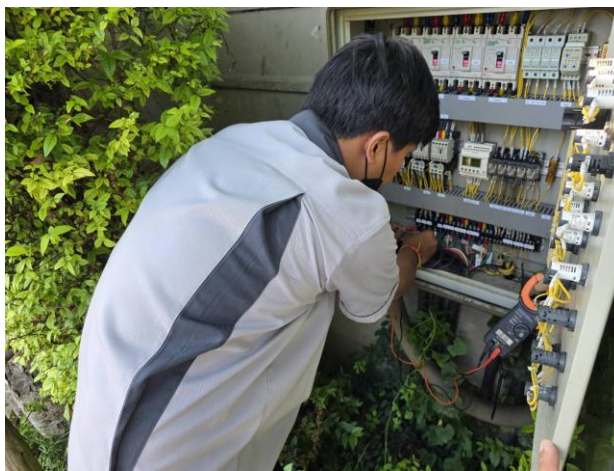
ช่างอาคารฯ ตรวจสอบใช้ระบบเดรนปั๊มป้องกันน้ำท่วมโครงการ (ตามแผนงาน)
