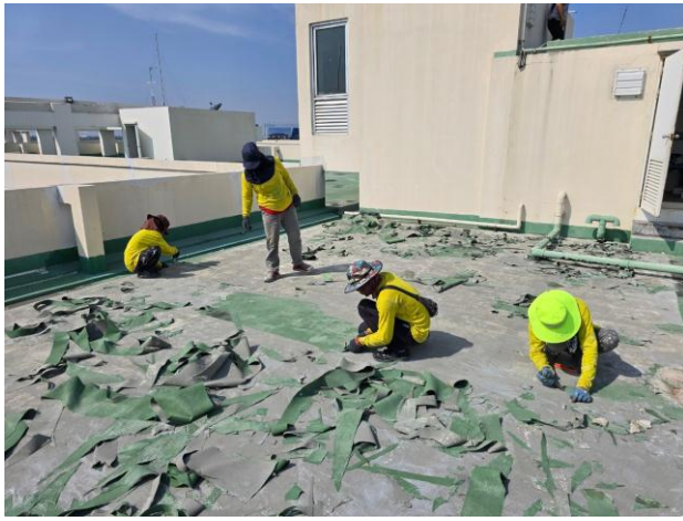
ผู้รับเหมา ดำเนินการทำกันซึมชั้นดาดฟ้า อาคาร B
