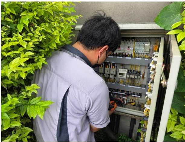
ช่างอาคารฯ ตรวจสอบเช็คระบบเดรนปั๊มป้องกันน้ำท่วมอาคาร (ตามแผนงาน)
