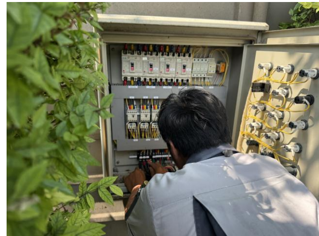
ช่างอาคารฯ ตรวจสอบใช้ระบบเตือนภัยป้องกันวงจรไฟฟ้า (ตามแผนงาน)
