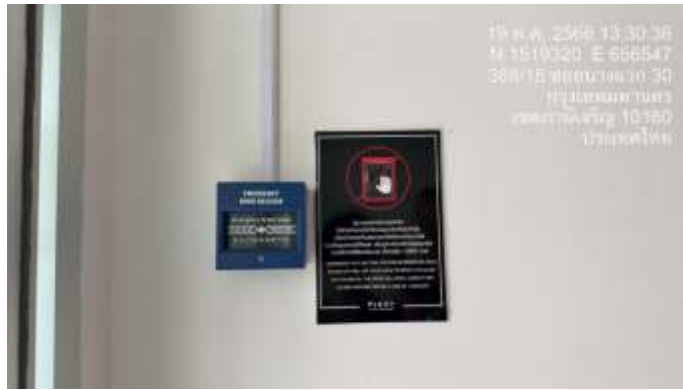
รูปที่ 23 ระบบเปิดประตูทางออกเมื่อเกิดเหตุฉุกเฉินเท่านั้น
