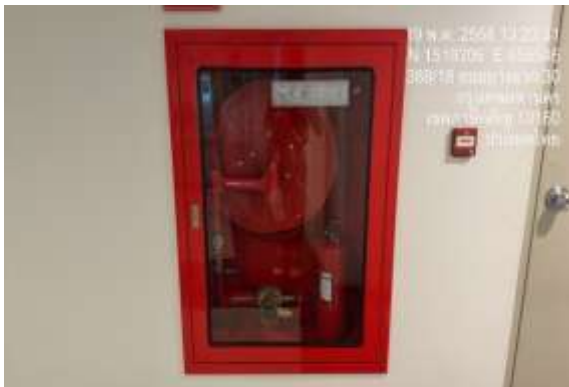
รูปที่ 38 ตู้เก็บสายฉีดน้ำดับเพลิง
