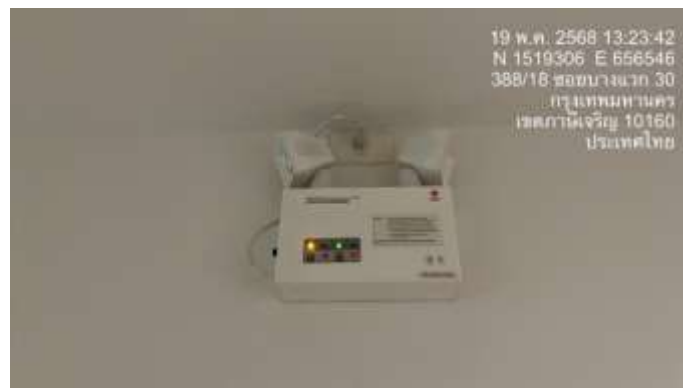
รูปที่ 42 ไฟส่องสว่างฉุกเฉิน
