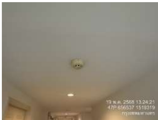
รูปที่ 35 อุปกรณ์ตรวจจับควันอัตโนมัติ
