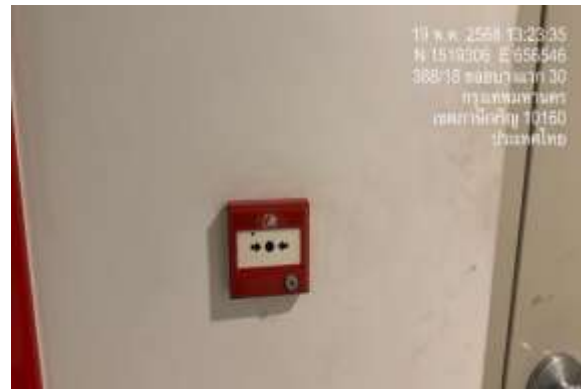
รูปที่ 32 อุปกรณ์แจ้งเหตุเพลิงไหม้แบบใช้มือ
