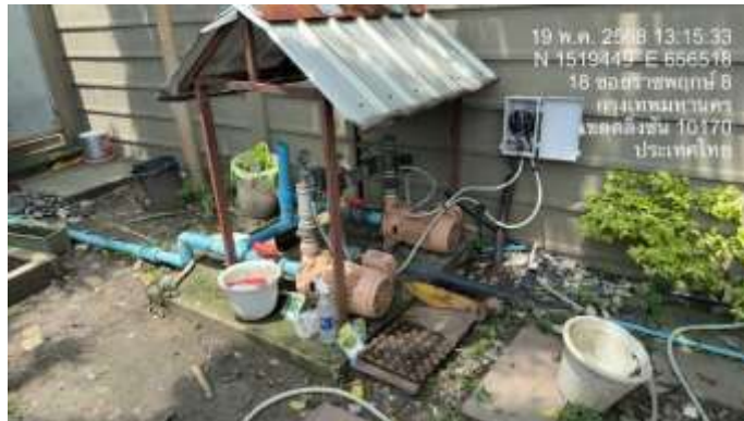
รูปที่ 14 ระบบน้ำทิ้งที่ผ่านการบำบัดแล้วมาใช้น้ำต้นไม้
