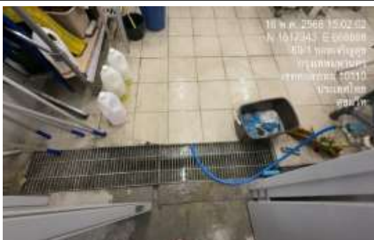
รูปที่ 24 ระบบระบายน้ำภายในห้องพักขยะรวม
