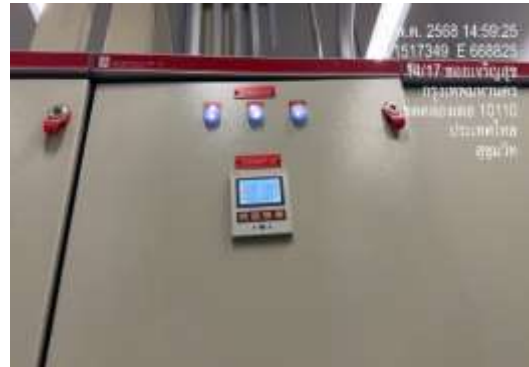
รูปที่ 29 มิเตอร์ไฟฟ้าแยกเฉพาะส่วนของระบบบำบัดน้ำเสีย
