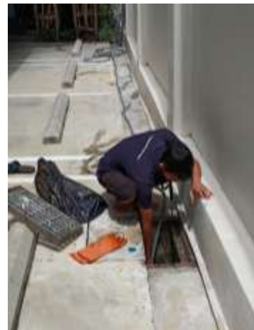
รูปที่ 59 การขุดลอกตะกอนระบบระบายน้ำภายในโครงการ
