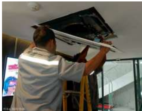
รูปที่ 57 การล้างเครื่องปรับอากาศในพื้นที่ส่วนกลาง
