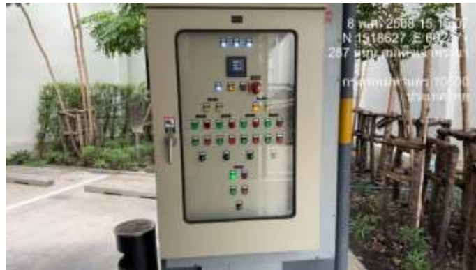
รูปที่ 28 ตู้ควบคุมระบบบำบัดน้ำเสียและมิเตอร์น้ำเสีย
