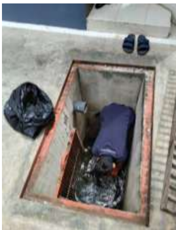
รูปที่ 59 การขุดลอกตะกอนระบบระบายน้ำภายในโครงการ
