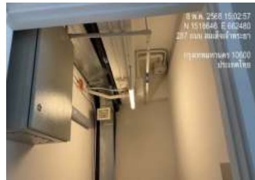
รูปที่ 11 เครื่องดูดกลิ่นห้องพัสดุ
