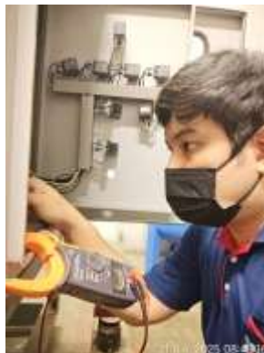
รูปที่ 40 เจ้าหน้าที่ตรวจสอบบำรุงรักษาอุปกรณ์ไฟฟ้า
