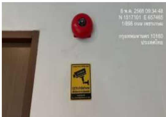
รูปที่ 29 อุปกรณ์ส่งสัญญาณแจ้งเหตุอัคคีภัย
