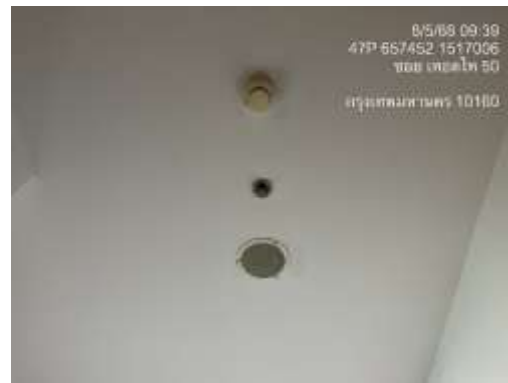
รูปที่ 31 เครื่องตรวจจับความร้อนและเครื่องตรวจจับควัน
