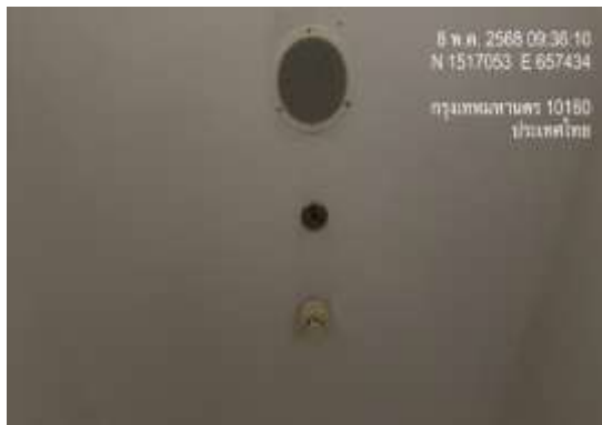
รูปที่ 31 เครื่องตรวจจับความร้อนและเครื่องตรวจจับควัน
