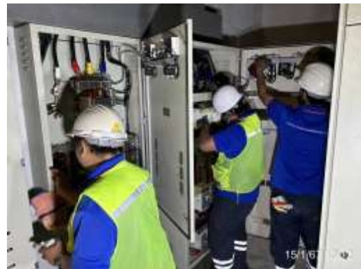
รูปที่ 40 เจ้าหน้าที่ตรวจสอบบำรุงรักษาอุปกรณ์ไฟฟ้า
