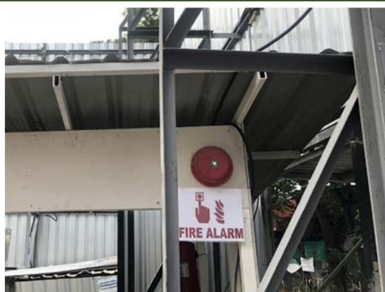
รูปที่ 2-59 ระบบสัญญาณแจ้งเหตุเพลิงไหม้
