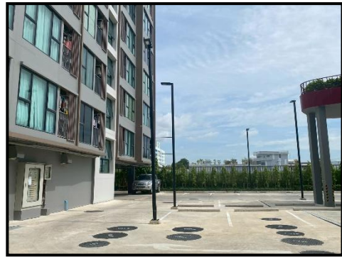
รูปที่ 2-10 ฝาดังระบบบำบัดน้ำเสียเป็นฝาดัง 2 ชั้น Double Seal
