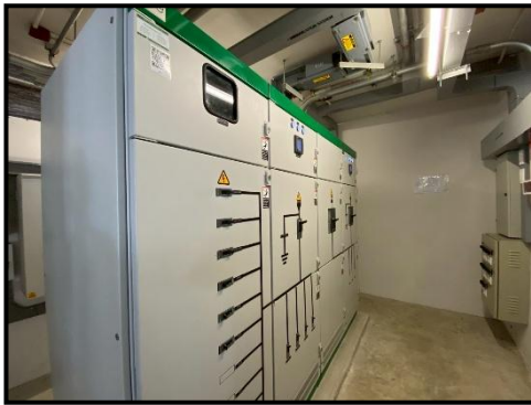
รูปที่ 2-19 มิเตอร์ไฟฟ้าสำหรับระบบบำบัดน้ำเสียของโครงการแยกจากระบบไฟฟ้าอื่นๆ
