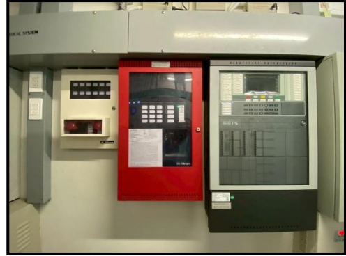
รูปที่ 2-36 แผงควบคุมระบบเตือนอัคคีภัย
