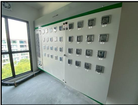
รูปที่ 2-21 ห้องควบคุมไฟฟ้าประจำชั้น
