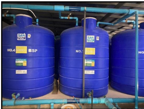
รูปที่ 2-23 ถังเก็บน้ำชั้นหลังคา
