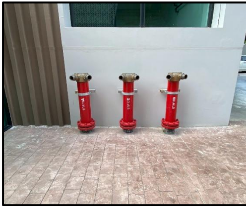
รูปที่ 2-41 หัวรับน้ำดับเพลิงภายนอกอาคาร
