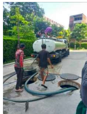
การสูบน้ำส่วนเกินจากระบบบำบัดน้ำเสีย
