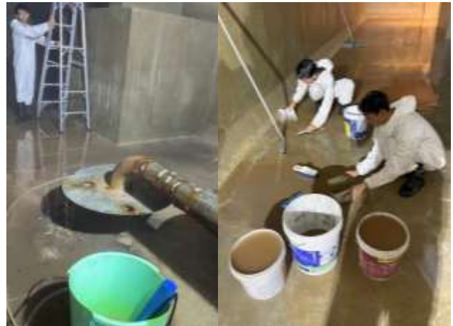
การทำความสะอาดถังเก็บน้ำใช้ ภาพที่ 2-8 (ต่อ) ระบบน้ำใช้ของโครงการ
