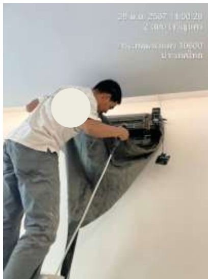
ภาพที่ 2-17 การล้างเครื่องปรับอากาศ
