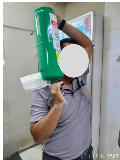
รูปภาพที่ 2.35 การตรวจสอบอุปกรณ์ป้องกันและแจ้งเตือนอัคคีภัย
