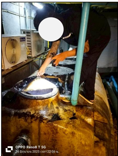
รูปภาพที่ 2.40 การสูบตะกอน
