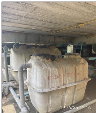
รูปภาพที่ 2.26 ระบบบำบัดน้ำเสีย
