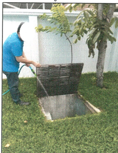
รูปภาพที่ 2.48 การขุดลอกตะกอนในรางระบายน้ำ
