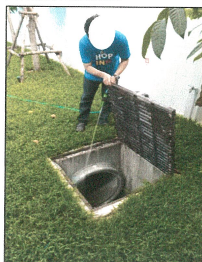
รูปภาพที่ 2.48 การขุดลอกตะกอนในรางระบายน้ำ
