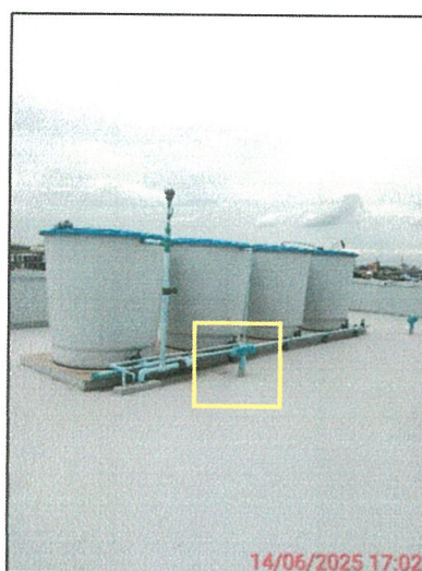
รูปภาพที่ 2.47 ท่อระบายก๊าซมีเทนจากบ่อเกรอะ
