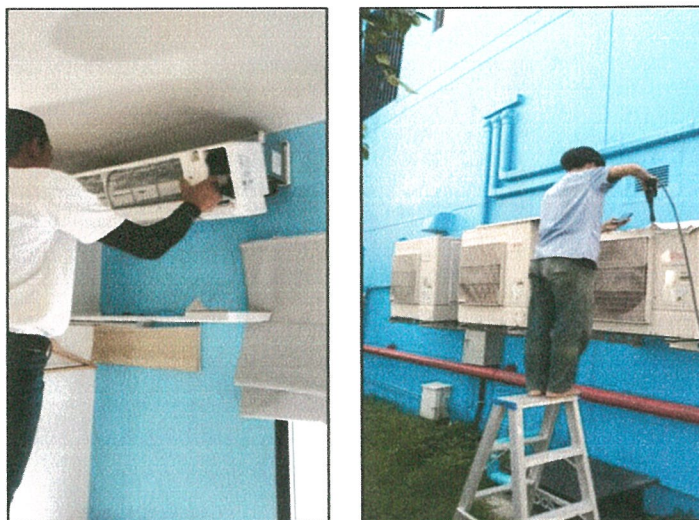
รูปภาพที่ 2.33 การล้างทำความสะอาดเครื่องปรับอากาศ
