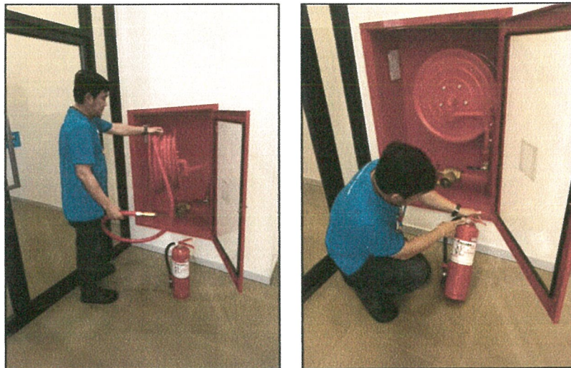
รูปภาพที่ 2.49 การตรวจสอบอุปกรณ์ป้องกันอัคคีภัย
