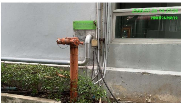
ภาพที่ 2-63 หัวรับน้ำดับเพลิงภายนอกอาคาร บริเวณด้านหน้าอาคารพักอาศัยและอาคารจอดรถ
