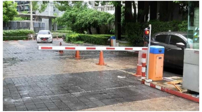
ภาพที่ 2-30 เครื่องกั้นอัตโนมัติ ควบคุมการเข้า-ออกของรถ
