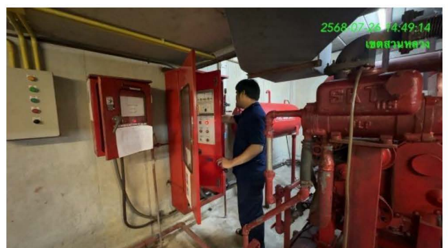
ภาพที่ 2-67 การตรวจสอบและบำรุงรักษาปั้มน้ำดับเพลิง
