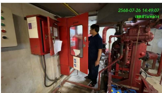
ภาพที่ 2-67 การตรวจสอบและบำรุงรักษาปั้มน้ำดับเพลิง
