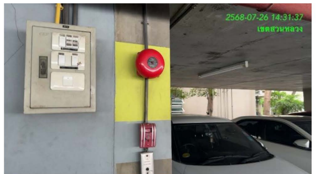
ภาพที่ 2-56 อุปกรณ์แจ้งเหตุสัญญาณเตือนเพลิงไหม้ในอาคาร
