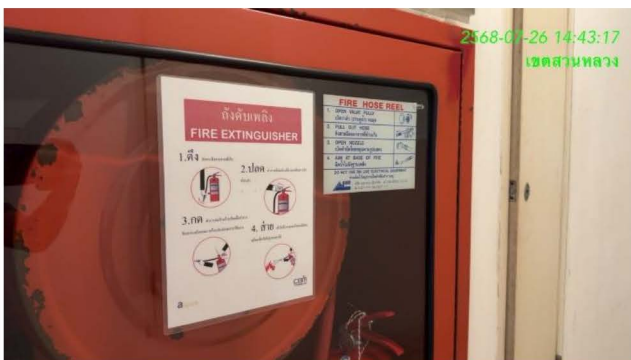
ภาพที่ 2-61 ตู้เก็บสายฉีดน้ำดับเพลิงในอาคารจอดรถ
