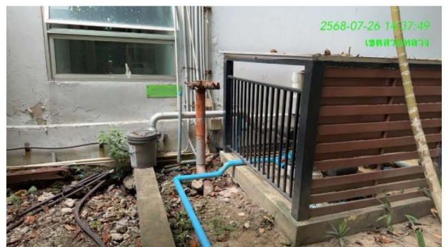
ภาพที่ 2-63 หัวรับน้ำดับเพลิงภายนอกอาคาร บริเวณด้านหน้าอาคารพักอาศัยและอาคารจอดรถ
