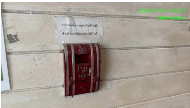
ภาพที่ 2-56 อุปกรณ์แจ้งเหตุสัญญาณเตือนเพลิงไหม้ในอาคาร
