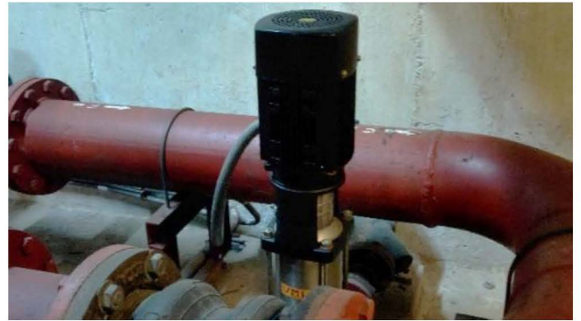
ภาพที่ 2-58 เครื่องสูบน้ำรักษาแรงดัน
