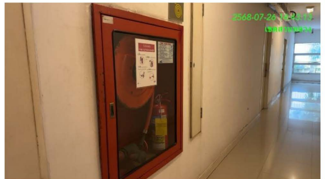
ภาพที่ 2-60 ตู้เก็บสายฉีดน้ำดับเพลิง
