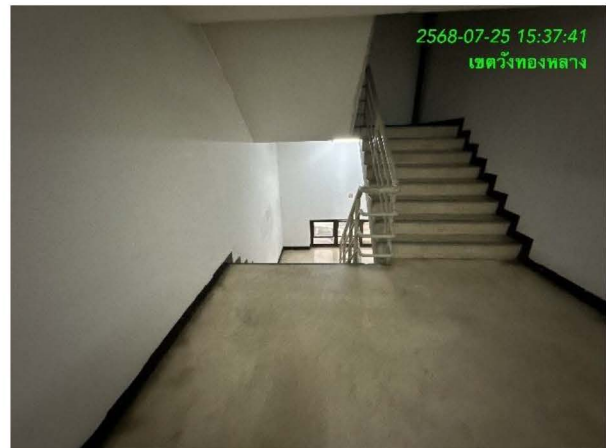
ภาพที่ 2-25 ผนังด้านที่บันไดหนีไฟพาดผ่านเป็นผนังกันไฟ
