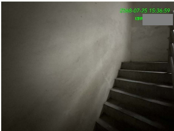
ภาพที่ 2-25 ผนังด้านที่บันไดหนีไฟพาดผ่านเป็นผนังกันไฟ
