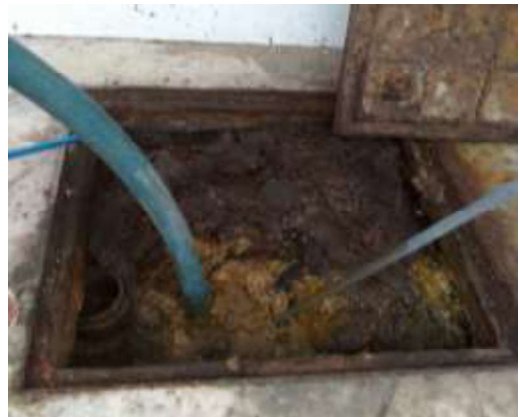
ภาพที่ 2-10 เจ้าหน้าที่สูบกําจัดตะกอนระบบบำบัดน้ำเสีย
