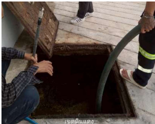
ภาพที่ 2-10 เจ้าหน้าที่สูบกําจัดตะกอนระบบบำบัดน้ำเสีย
