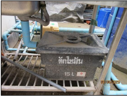
รูปที่ 45 ถังดับไฮดรัน และระบบบำบัดน้ำเสียแบบสำเร็จรูป ภายในพื้นที่ก่อสร้าง
