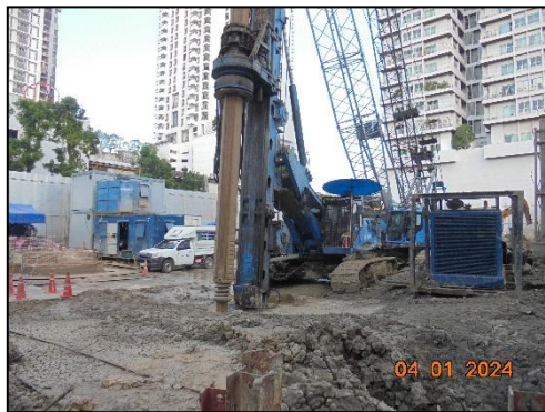
รูปที่ 31 เครื่องเจาะเสาเข็ม
