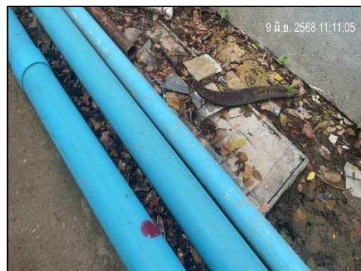
รูปที่ 1-6 ท่อระบายน้ำชั่วคราวรอบบริเวณพื้นที่โครงการ
