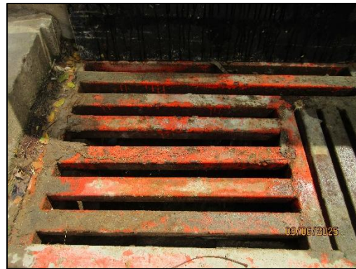
รูปที่ 1-7 ตะแกรงดักขยะบริเวณปากท่อระบายน้ำ
