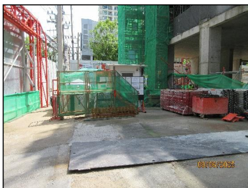
รูปที่ 27 แผ่นเหล็กปูเส้นทางเดินรถ ภายในพื้นที่ก่อสร้าง
