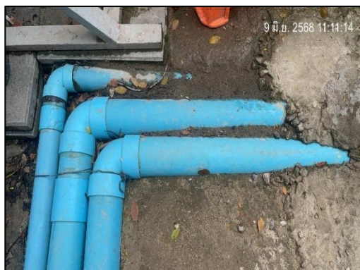
รูปที่ 1-6 ท่อระบายน้ำชั่วคราวรอบบริเวณพื้นที่โครงการ
