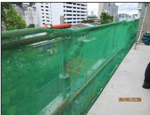
รูปที่ 126 ผ้าใบ (Mesh Sheet) คลุมรอบอาคาร
