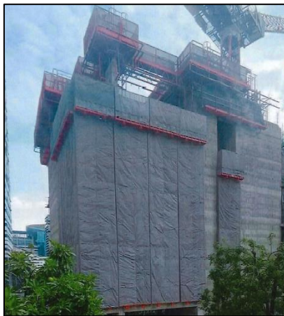
รูปที่ 126 ผ้าใบ (Mesh Sheet) คลุมรอบอาคาร
