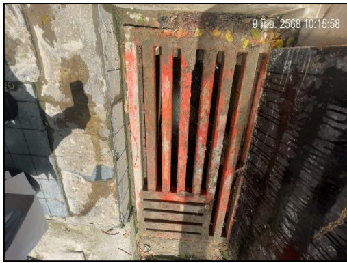
รูปที่ 1-7 ตะแกรงดักขยะบริเวณปากท่อระบายน้ำ
