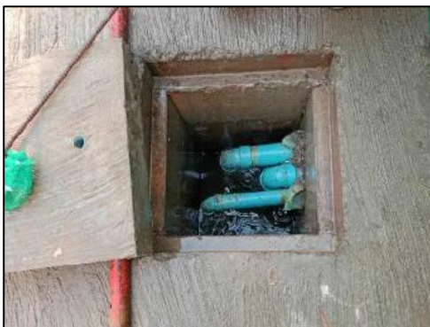
รูปที่ 29 บ่อคัดตะกอนภายในพื้นที่โครงการ
