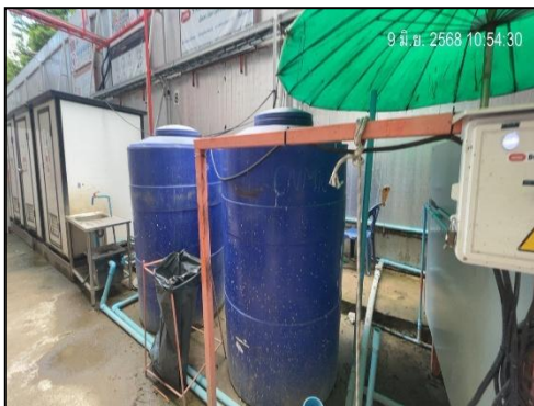
รูปที่ 57 ระบบน้ำประปา และถังสำรองน้ำใช้ภายในพื้นที่โครงการ
