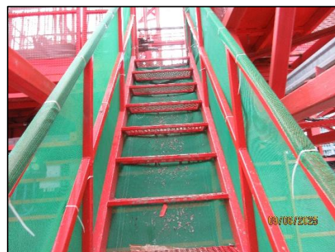
รูปที่ 127 แผงกันวัสดุตกหล่นจากตัวอาคาร
