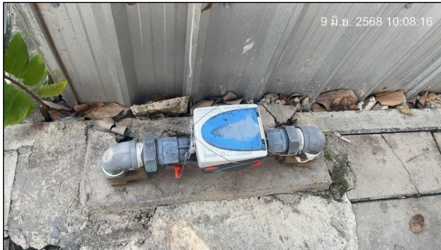
รูปที่ 1-5 ติดตั้งมิเตอร์น้ำประปาภายในพื้นที่โครงการ
