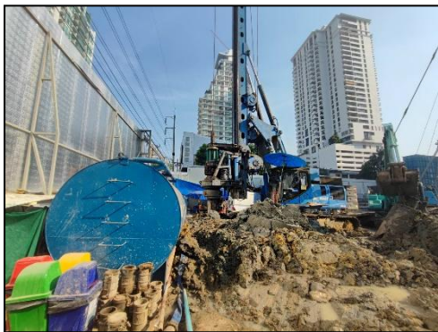
รูปที่ 31 เครื่องเจาะเสาเข็ม
