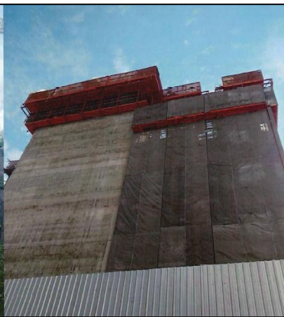
รูปที่ 126 ผ้าใบ (Mesh Sheet) คลุมรอบอาคาร
