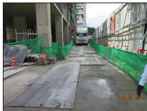
รูปที่ 27 แผ่นเหล็กปูเส้นทางเดินรถ ภายในพื้นที่ก่อสร้าง
