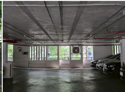
ช่องระบายอากาศ และพัดลมระบายอากาศ
