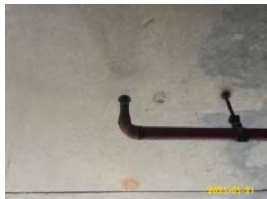
ระบบดับเพลิงอัตโนมัติด้วยน้ำ (Sprinkler System)
