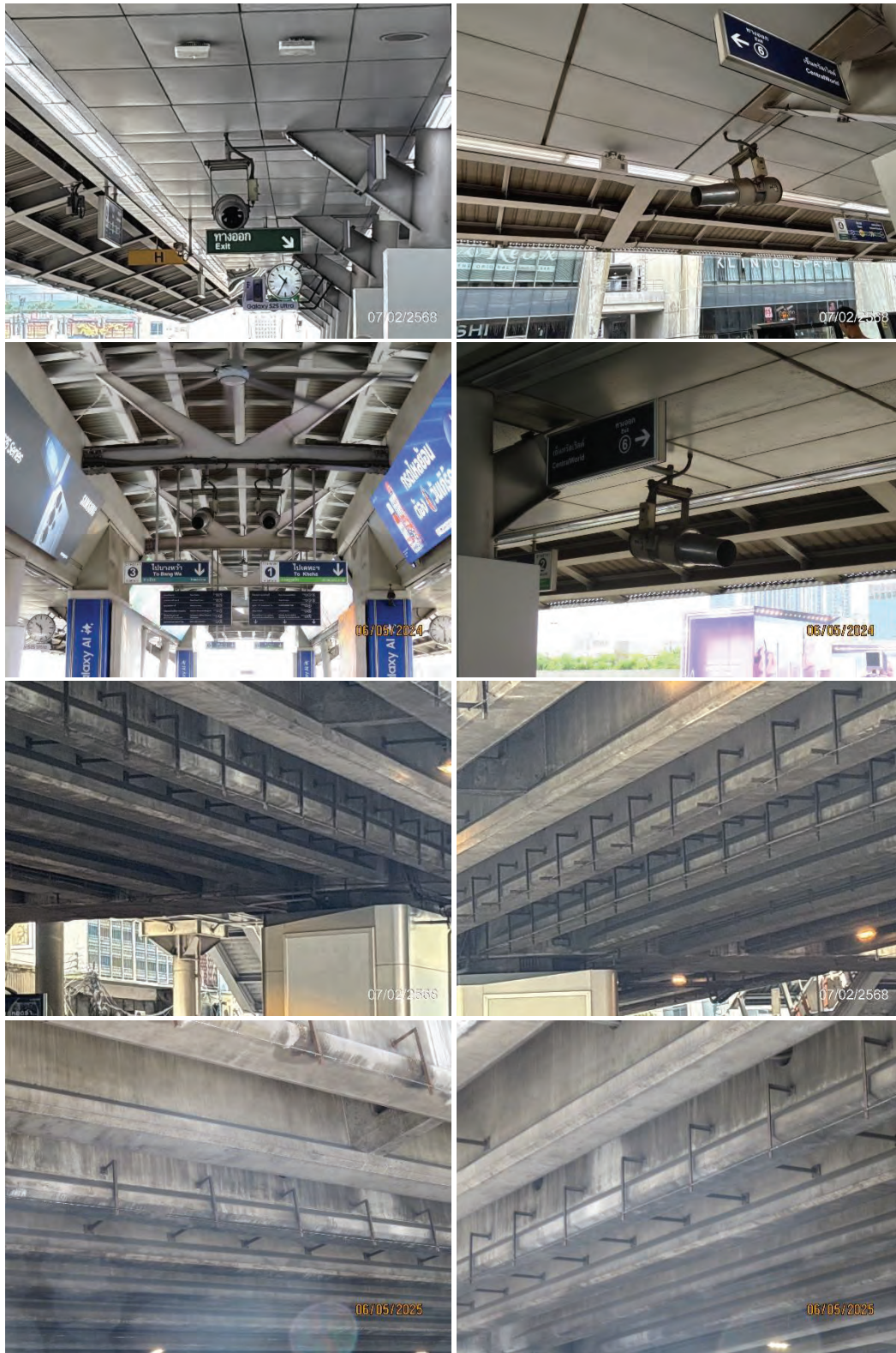
ภาพที่ 1.2-7 การดำเนินการตามมาตรการป้องกันและแก้ไขผลกระทบสิ่งแวดล้อมด้านมลพิษทางอากาศ ติดตั้งพัดลมเป่าอากาศเพื่อช่วยระบายอากาศ บริเวณสถานีสยาม และระบบฟ่นละอองน้ำ แรงดันสูงเพื่อลดความเข้มข้นของมลสารบริเวณใต้สถานีรถไฟฟ้า
