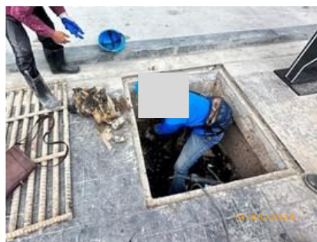
รูปที่ 3-40 การตรวจสอบรางระบายน้ำ และการลอกรางระบายน้ำ
