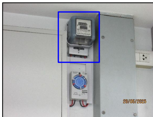
มิเตอร์ไฟฟ้าสำหรับระบบบำบัดน้ำเสีย
