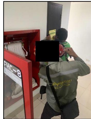
รูปที่ 66 เจ้าหน้าที่ตรวจเช็คถังดับเพลิงและอุปกรณ์ดับเพลิง
