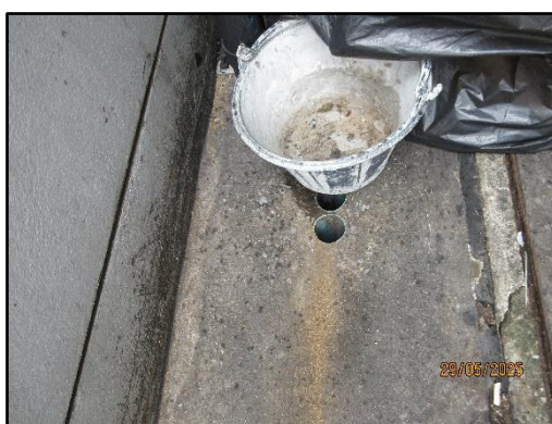
รูปที่ 29 ท่อระบายน้ำชะล้างห้องพัสดุฝอยรวม เพื่อรวบรวมน้ำจากห้องพัทยะเข้าระบบบำบัดก่อน ปล่อยออกสู่ท่อระบายน้ำสาธารณะ
