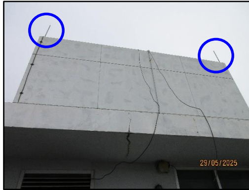
รูปที่ 61 ระบบป้องกันฟ้าผ่า
