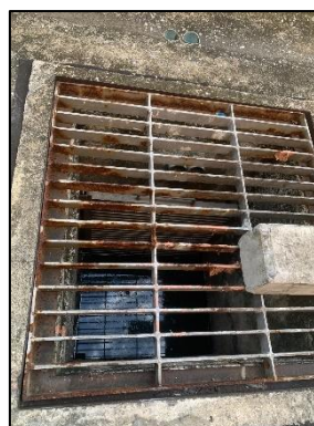
รูปที่ 17 ท่อระบายน้ำ พร้อมตะแกรงดักขยะ
