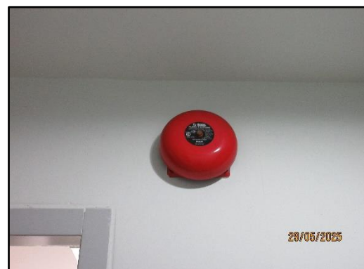
รูปที่ 50 ชุดกดแจ้งเหตุและกระดิ่งแจ้งสัญญาณเพลิงไหม้
