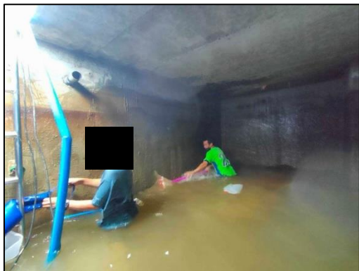
รูปที่ 15 การดูแล ทำความสะอาดถังเก็บน้ำสำรองของโครงการ
