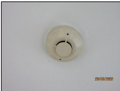
รูปที่ 51 อุปกรณ์ตรวจจับควัน ตรวจจับความร้อน
