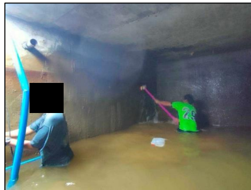
รูปที่ 15 การดูแล ทำความสะอาดถังเก็บน้ำสำรองของโครงการ
