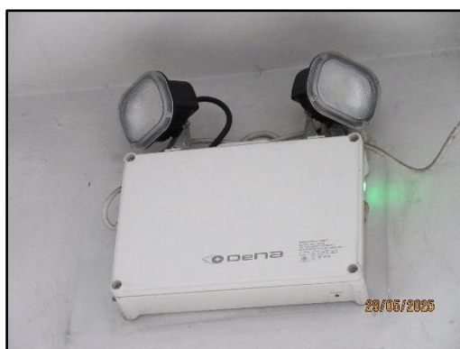
รูปที่ 60 ไฟฉุกเฉิน ระบบไฟสำรองฉุกเฉิน
