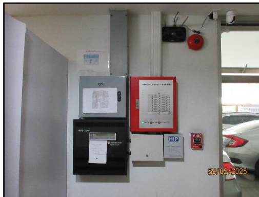
รูปที่ 63 Graphic annunciator fire alarm system
