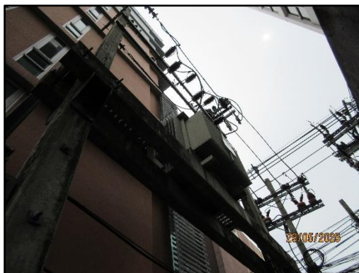
รูปที่ 31 หม้อแปลงไฟฟ้าของโครงการ
