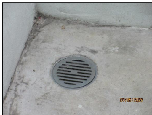
รูปที่ 28 ท่อระบายน้ำชะล้างห้องพัสดุฝอยในแต่ละชั้น
