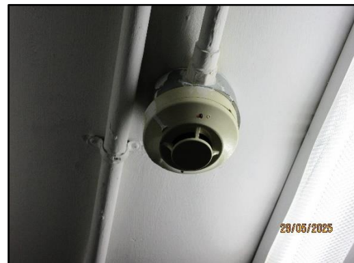
รูปที่ 51 อุปกรณ์ตรวจจับควัน ตรวจจับความร้อน
