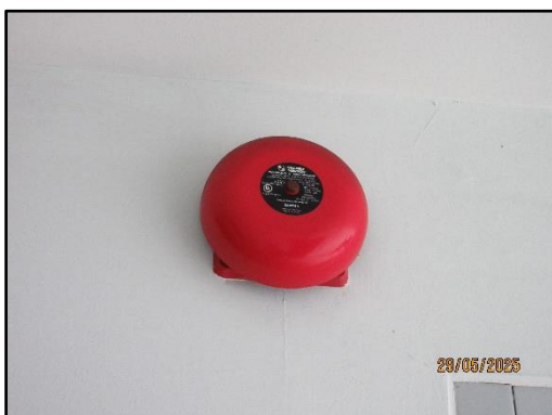
รูปที่ 50 ชุดกดแจ้งเหตุและกระดิ่งแจ้งสัญญาณเพลิงไหม้
