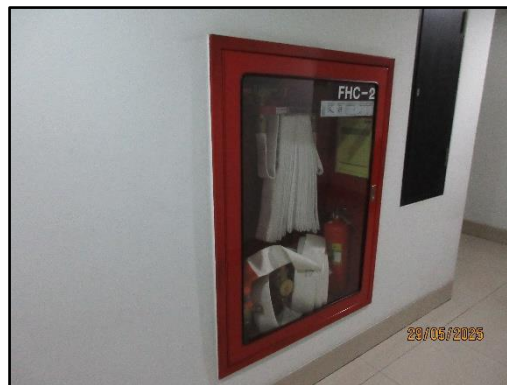
รูปที่ 53 ตู้หัวฉีดน้ำดับเพลิง
