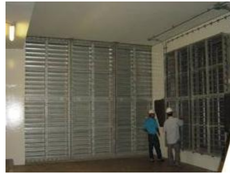
ภาพที่ 2.2-6 ปล่องระบายอากาศจากใต้ชั้นขนาขาลาดสู่ภายนอก
