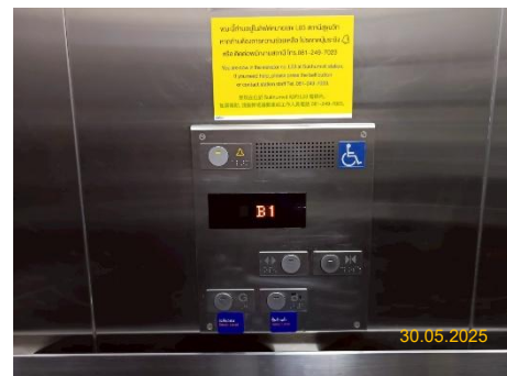
ภาพที่ 2.2-22 สัญลักษณ์และอักษรเบรลล์ภายในลิฟต์สำหรับผู้พิการ
