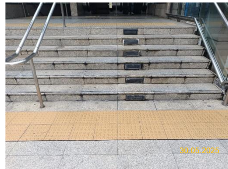
ภาพที่ 2.2-27 กระเบื้องปูพื้นพิเศษบอกระดับสำหรับผู้พิการทางสายตา
