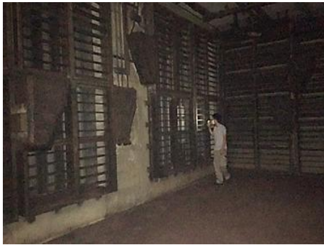
ภาพที่ 2.2-6 ปล่องระบายอากาศจากใต้ชั้นขนาขาลาดสู่ภายนอก
