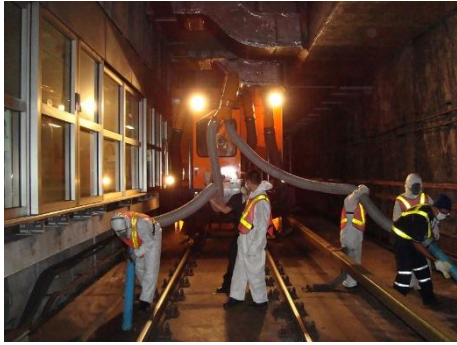
ภาพที่ 2.2-1 การดูฝุ่นอุโมงค์ และการสวมใส่อุปกรณ์ป้องกันขณะปฏิบัติงาน
