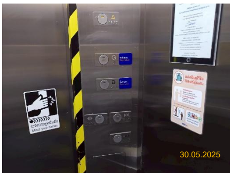
ภาพที่ 2.2-22 สัญลักษณ์และอักษรเบรลล์ภายในลิฟต์สำหรับผู้พิการ
