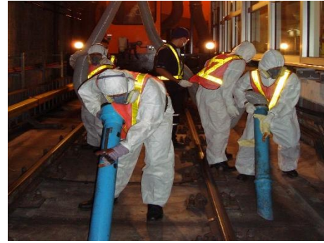
ภาพที่ 2.2-1 การดูฝุ่นอุโมงค์ และการสวมใส่อุปกรณ์ป้องกันขณะปฏิบัติงาน
