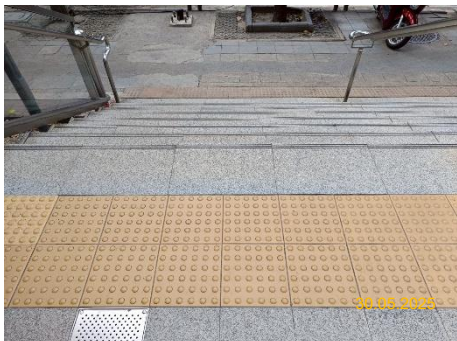
ภาพที่ 2.2-27 กระเบื้องปูพื้นพิเศษบอกระดับสำหรับผู้พิการทางสายตา
