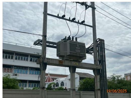
รูปที่ 10 หม้อแปลงไฟฟ้า
