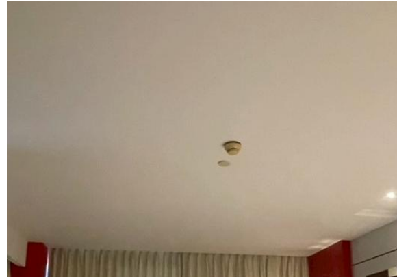
ภาพที่ 17 เครื่องตรวจจับควันและความร้อน
