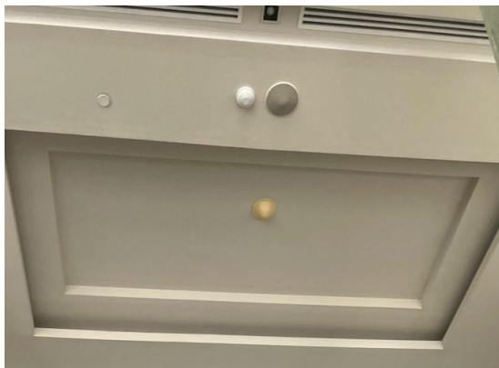
ภาพที่ 17 เครื่องตรวจจับควันและความร้อน
