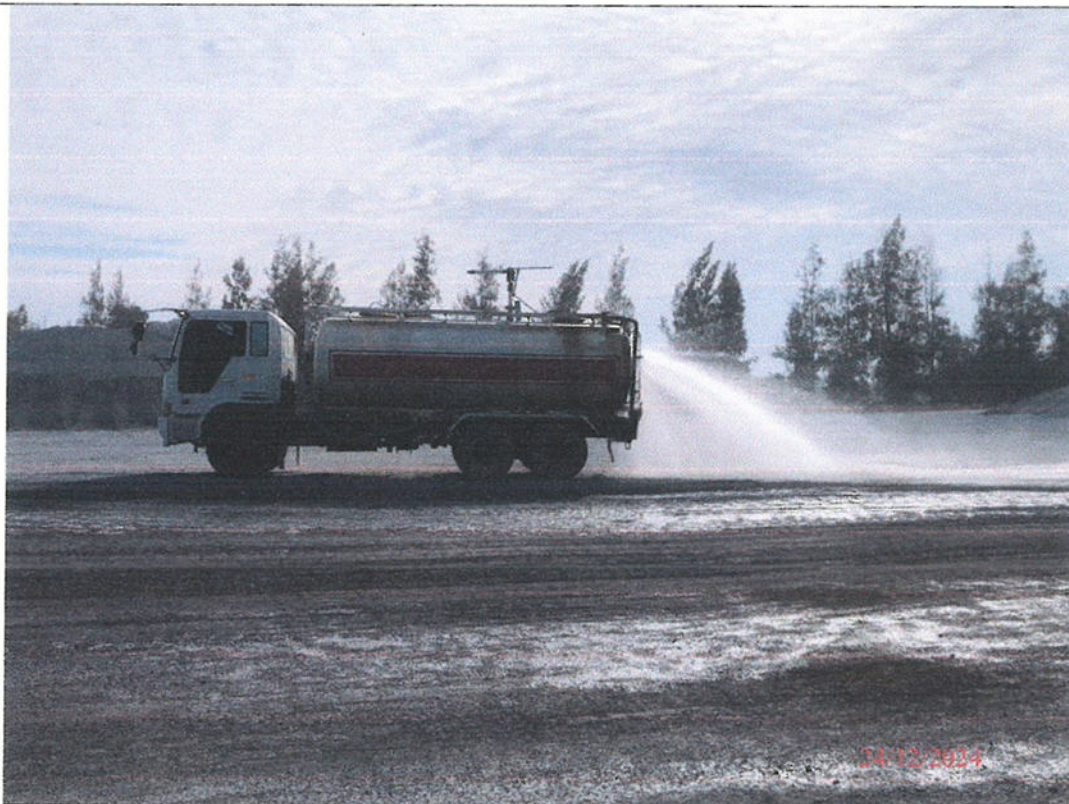
ภาพที่ 8 : การนำน้ำจากบ่อกักน้ำตักตะกอนมาใช้ลาดถนนและพื้นที่ต่างๆที่เกิดฝุ่นฟุ้งกระจาย
