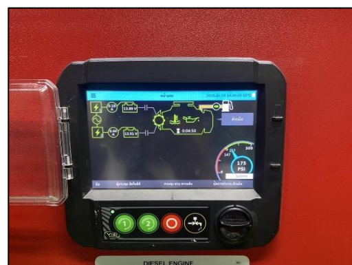
รูปที่ 18 (ต่อ) การทดสอบและเดินเครื่องกำเนิดไฟฟ้าสำรอง และเครื่องสูบน้ำดับเพลิง
