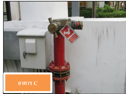
รูปที่ 71 หัวรับน้ำดับเพลิงนอกอาคาร (FIRE DEPARTMENT CONNECTION: FDC)
