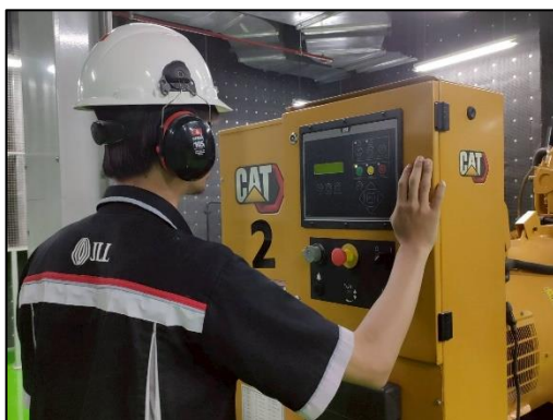
รูปที่ 18 การทดสอบและเดินเครื่องกำเนิดไฟฟ้าสำรอง และเครื่องสูบน้ำดับเพลิง
