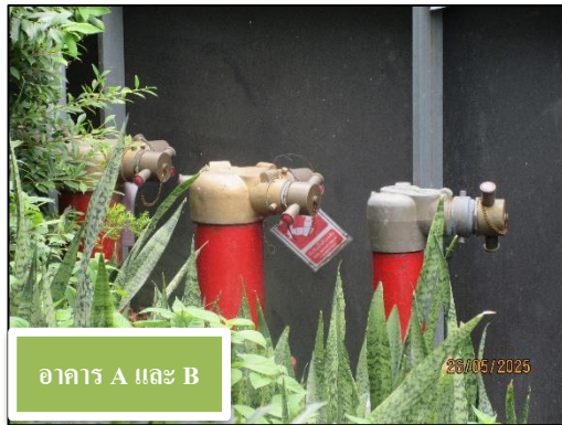
รูปที่ 71 หัวรับน้ำดับเพลิงนอกอาคาร (FIRE DEPARTMENT CONNECTION: FDC)
