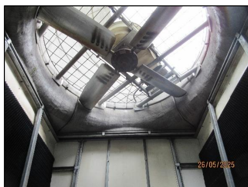
รูปที่ 11 หอผึ่งเย็น (Cooling Tower)
