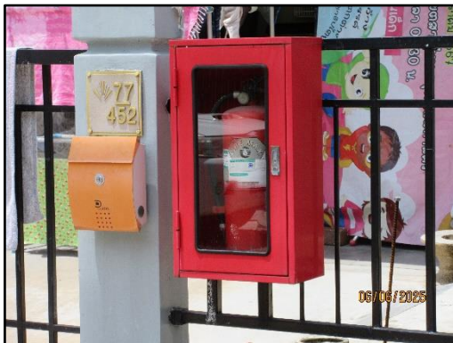
รูปที่ 32 (ต่อ) หัวจ่ายน้ำดับเพลิง และถังดับเพลิงเคมีแบบมือถือ
