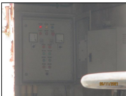
รูปที่ 9 มิเตอร์ไฟเฉพาะสำหรับระบบบำบัดน้ำเสีย และตู้ควบคุมระบบน้ำเสีย
