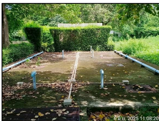
รูปที่ 5 ท่อระบายอากาศ ของระบบบำบัดน้ำเสีย
