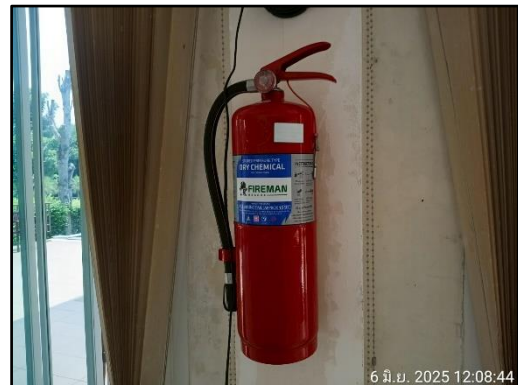
รูปที่ 32 (ต่อ) หัวจ่ายน้ำดับเพลิง และถังดับเพลิงเคมีแบบมือถือ
