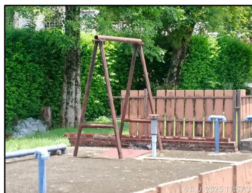
รูปที่ 5 ท่อระบายอากาศ ของระบบบำบัดน้ำเสีย
