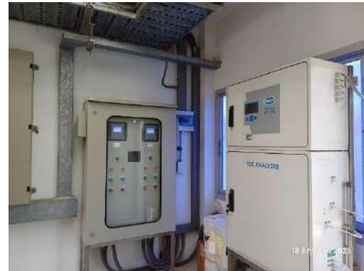
รูปที่ 2-16 การติดตั้งเครื่องตรวจวัด DO online และ BOD/COD online บริเวณบ่อพักน้ำทิ้ง (Holding Pond)
