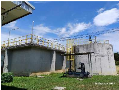
รูปที่ 2-12 ระบบบำบัดน้ำเสียส่วนกลางของนิคมฯ
