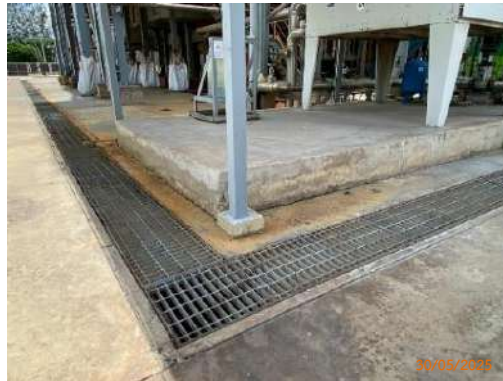
รูปที่ 2-11 ระบบระบายน้ำเสียของโรงงาน
