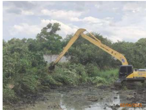
รูปที่ 2-28 การขุดลอกคลองสองคอน(ลำรางสาธารณะ)
