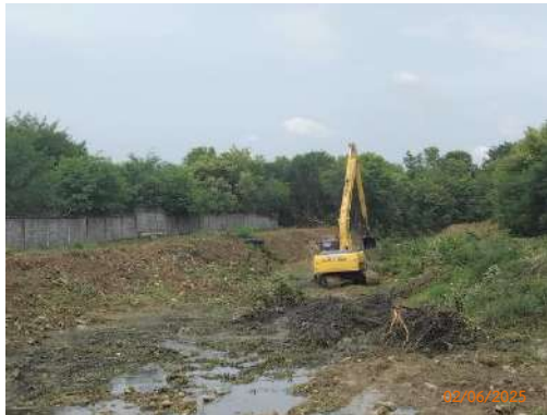
รูปที่ 2-28 การขุดลอกคลองสองคอน(ลำรางสาธารณะ)
