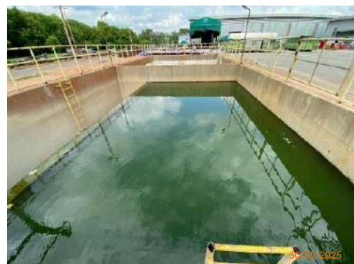
รูปที่ 2-10 บ่อพักน้ำทิ้งของโรงงาน (Inspection Manhole)
