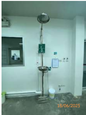
รูปที่ 2-38 ฝักบัวฉุกเฉิน และอ่างล้างตา บริเวณพื้นที่เสี่ยง
