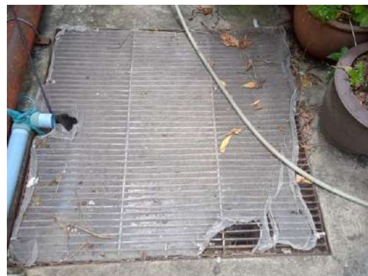
ภาพที่ 22 ตะแกรงดักขยะ
