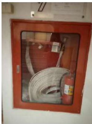
ภาพที่ 15 สายฉีดน้ำดับเพลิง
