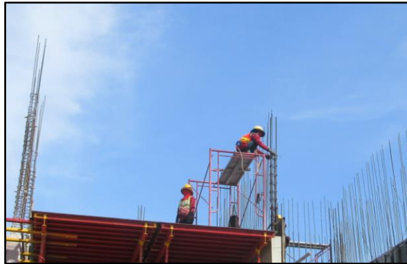
รูปที่ 56 นั่งร้านภายในพื้นที่ก่อสร้าง
