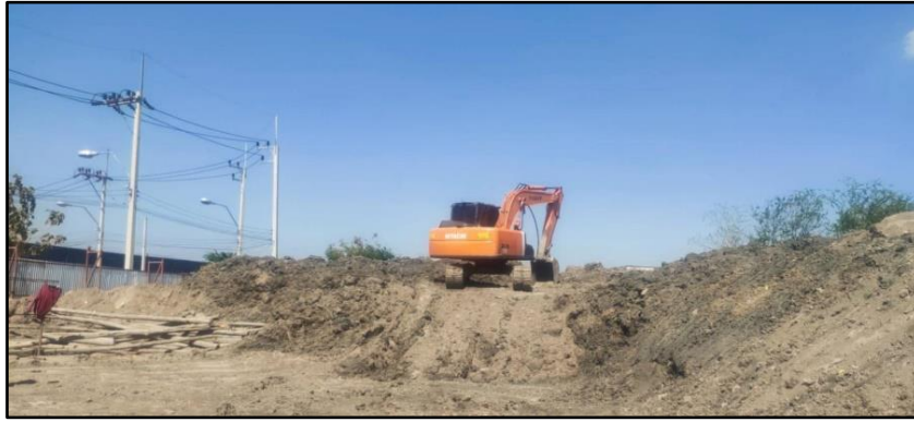
รูปที่ 59 กองดินที่ขุดออกจากการก่อสร้างฐานรากเก็บไว้ในพื้นที่ปิดล้อมเป็นสัดส่วนไว้ในพื้นที่เฉพาะ
