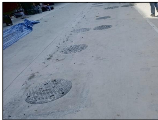
รูปที่ 37 ถึงบำบัดน้ำเสียสำเร็จรูปบริเวณพื้นที่ก่อสร้าง
