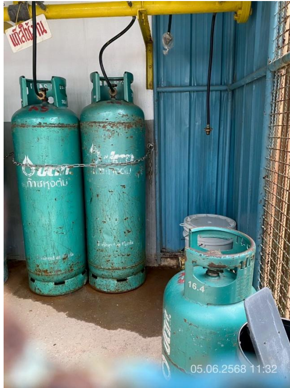
ภาพที่ 23 แสดงการรั่วถังก๊าซ ภายในห้องเก็บก๊าซหุงต้ม
