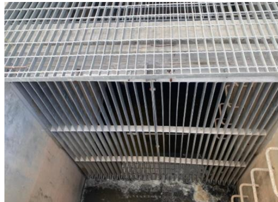
รูปที่ 2-18 ตะแกรงเพื่อดักเศษขยะบริเวณบ่อพักน้ำทิ้ง (Holding Pond)
