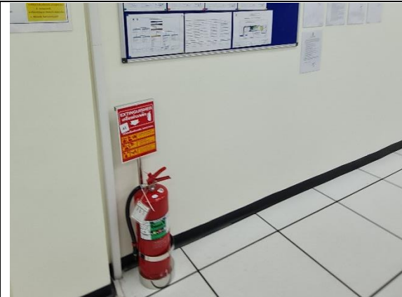
รูปที่ 2-11 ถังดับเพลิง ชนิดมือถือบริเวณ ห้องควบคุม
