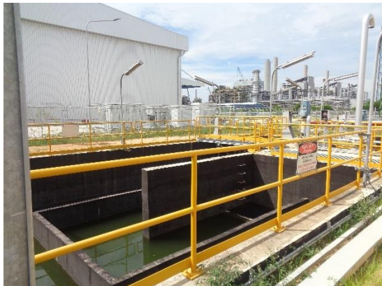
รูปที่ 2-17 บ่อพักน้ำทิ้ง (Holding Pond)
