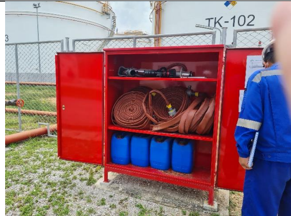
รูปที่ 2-12 ตู้อุปกรณ์ดับเพลิง
