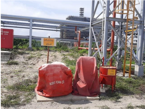
รูปที่ 2-9 ถังโฟมและถังทรายดับเพลิง บริเวณหน้าท่า
