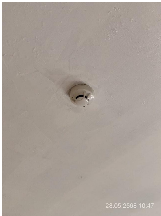
ภาพที่ 3 แสดง Smoke Detector ภายในห้องพักแขก
