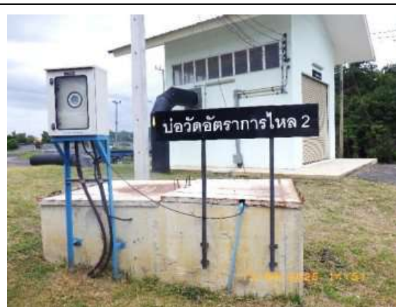
รูปที่ 2-28 ติดตั้ง Flow Meter
