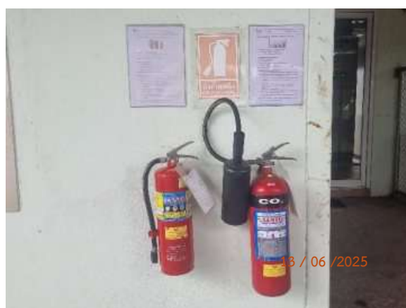
รูปที่ 2-49 อุปกรณ์ดับเพลิง
