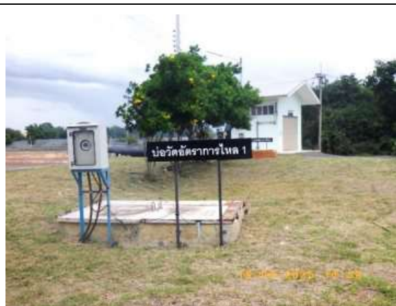
รูปที่ 2-28 ติดตั้ง Flow Meter
