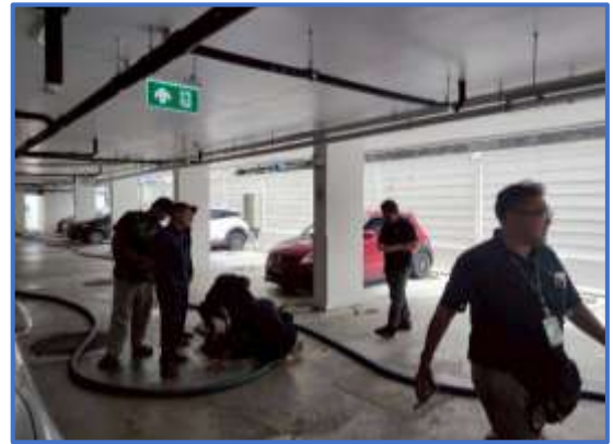
รูปที่ 41 เจ้าหน้าที่สูบลำโพงออกจากระบบ บำบัดน้ำเสีย
