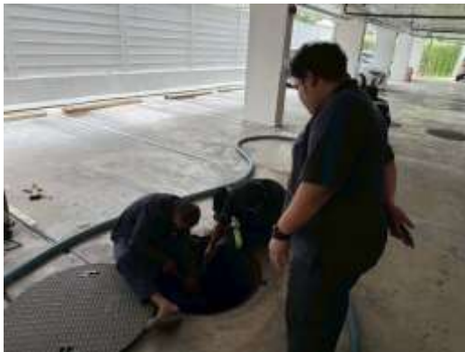
รูปที่ 41 เจ้าหน้าที่สูบลำโพงออกจากระบบ บำบัดน้ำเสีย
