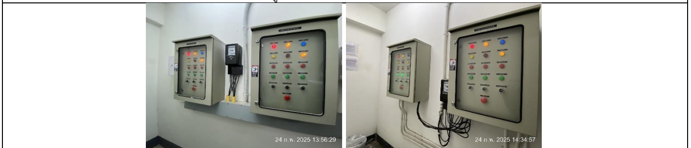
รูปที่ ๗.10 ระบบมอเตอร์ไฟฟ้าสำหรับระบบบำบัดน้ำเสีย อาคาร C และอาคาร D ตามลำดับ
