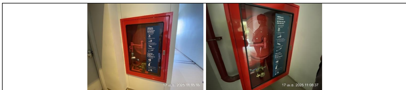
รูปที่ ฌ7.40 ตู้เก็บสายฉีดน้ำดับเพลิง และอุปกรณ์ (FHC) พร้อมทั้งป้ายแนะนำการใช้อุปกรณ์
