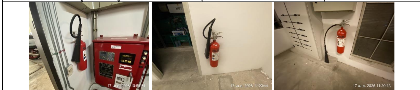
รูปที่ ฌ7.41 ถังดับเพลิงเคมีแบบมือถือ พร้อมทั้งป้ายแนะนำการใช้อุปกรณ์ บริเวณห้องเครื่องสูบน้ำ ห้องเครื่องกำเนิดไฟฟ้า ห้องเครื่องไฟฟ้าของโครงการ ตามลำดับ
