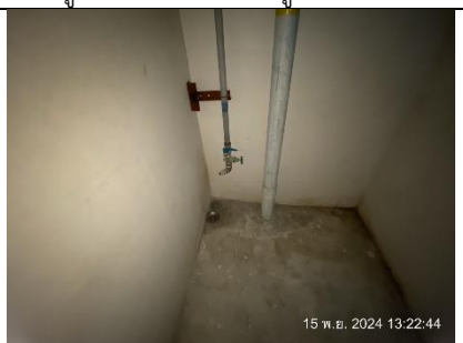
รูปที่ ฎ7.28 ท่อรวบรวมน้ำจากการล้างห้องพักมูลฝอยรวม
