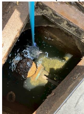
จุดที่ 3 คุณภาพน้ำก่อนปล่อยออกสู่ภายนอกโครงการ : บ่อพักน้ำสุดท้ายพร้อมตะแกรงดักขยะ
