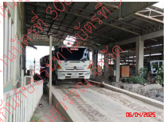
รูปที่ 20 จุดขังน้ำหนักรถบรรทุก และการควบคุมรถบรรทุกแร่ที่ออกนอกโครงการให้ผ่านจุดขังน้ำหนักรถบรรทุกออกได้ทีละ 1 คัน
