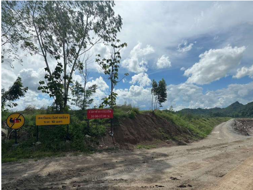
รูปที่ 8 แสดงคันทำนบดินสำหรับบดบังการทำเหมือง และป้ายเตือนต่างๆ ของพื้นที่โครงการ
