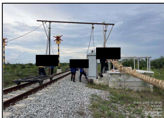
รูปที่ 1-6 งานก่อสร้าง Cable Trench and Laying Cable ติดตั้งฐานตู้สื่อสาร (LOC) และติดตั้งเสาสัญญาณ บริเวณสถานีบ่อตะคร้อ
