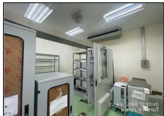
รูปที่ 1-7 งานติดตั้งฐานตู้สื่อสาร (LOC) และติดตั้งฐานเสาสัญญาณ บริเวณสถานีเพชรบุรี
