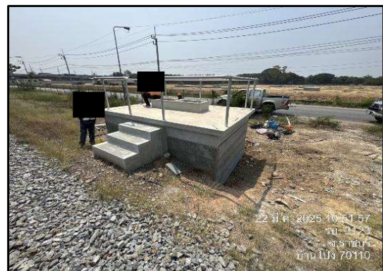
รูปที่ 1-4 งานติดตั้ง Generator ติดตั้งเสา Ratio Tower และงานฐานตู้สื่อสาร (LOC) บริเวณสถานีบ้านโป่ง
