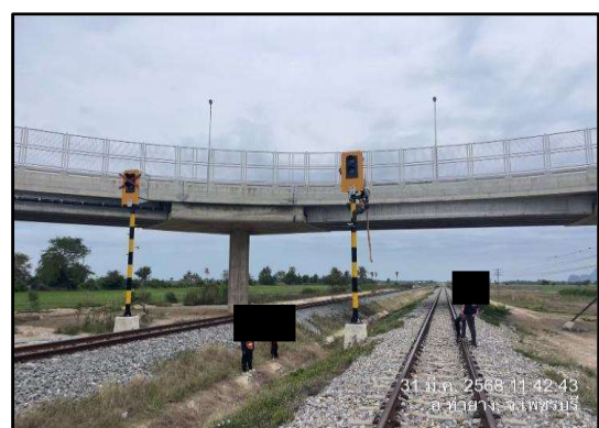
รูปที่ 1-8 งานติดตั้งอุปกรณ์ห้อง Relay Room ติดตั้งฐานตู้สื่อสาร (LOC). และติดตั้งเสาสัญญาณ บริเวณสถานีหนองศาลา
