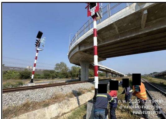
รูปที่ 1-3 งานติดตั้งอุปกรณ์ห้อง Relay Room ติดตั้งเสาสัญญาณ และติดตั้งฐานเสาสัญญาณ บริเวณสถานีคลองบางตาล
