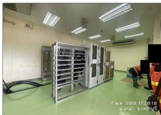
รูปที่ 1-7 งานติดตั้งฐานตู้สื่อสาร (LOC) และติดตั้งฐานเสาสัญญาณ บริเวณสถานีเพชรบุรี
