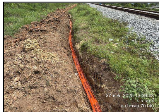
รูปที่ 1-5 งานก่อสร้างท่อร้อยสายลอดใต้ทางรถไฟ (UTX) บริเวณสถานีโพธาราม
