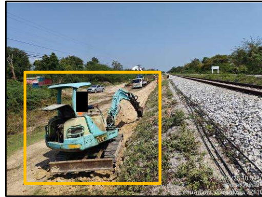
รูปที่ 2-8 การขุดเปิดและปิดหน้าดินงานก่อสร้าง Cable Trench and Laying Cable
