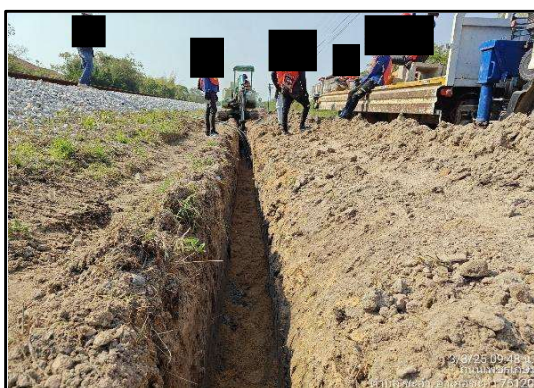
รูปที่ 1-10 งานบ่อ Main Cable Pit และงานก่อสร้าง Cable Trench and Laying Cable บริเวณสถานีห้วยทรายใต้
