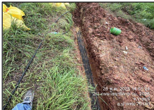
รูปที่ 1-5 งานก่อสร้างท่อร้อยสายลอดใต้ทางรถไฟ (UTX) บริเวณสถานีโพธาราม
