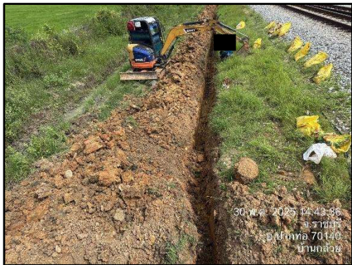
รูปที่ 2-9 การปรับสภาพพื้นที่ และการขุดดิน
