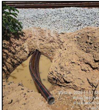
รูปที่ 1-5 งานก่อสร้างท่อร้อยสายลอดใต้ทางรถไฟ (UTX) บริเวณสถานีโพธาราม
