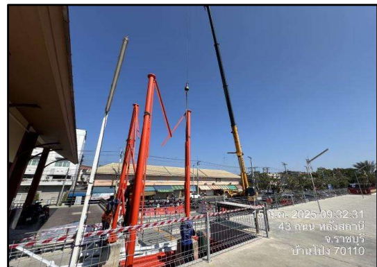
รูปที่ 1-3 งานติดตั้งอุปกรณ์ห้อง Relay Room ติดตั้งเสาสัญญาณ และติดตั้งฐานเสาสัญญาณ บริเวณสถานีคลองบางตาล
