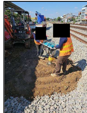
รูปที่ 1-5 งานก่อสร้างท่อร้อยสายลอดใต้ทางรถไฟ (UTX) บริเวณสถานีโพธาราม
