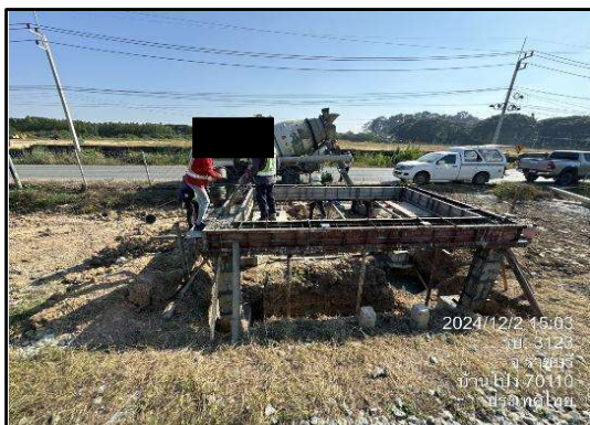
รูปที่ 1-4 งานติดตั้ง Generator ติดตั้งเสา Ratio Tower และงานฐานตู้สื่อสาร (LOC) บริเวณสถานีบ้านโป่ง
