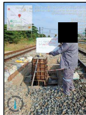
รูปที่ 1-7 งานติดตั้งฐานตู้สื่อสาร (LOC) และติดตั้งฐานเสาสัญญาณ บริเวณสถานีเพชรบุรี
