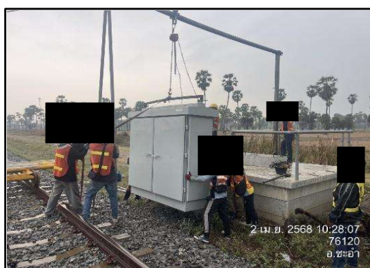
รูปที่ 1-8 งานติดตั้งอุปกรณ์ห้อง Relay Room ติดตั้งฐานตู้สื่อสาร (LOC). และติดตั้งเสาสัญญาณ บริเวณสถานีหนองศาลา
