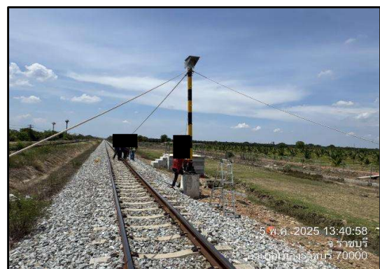
รูปที่ 1-6 งานก่อสร้าง Cable Trench and Laying Cable ติดตั้งฐานตู้สื่อสาร (LOC) และติดตั้งเสาสัญญาณ บริเวณสถานีบ่อตะคร้อ
