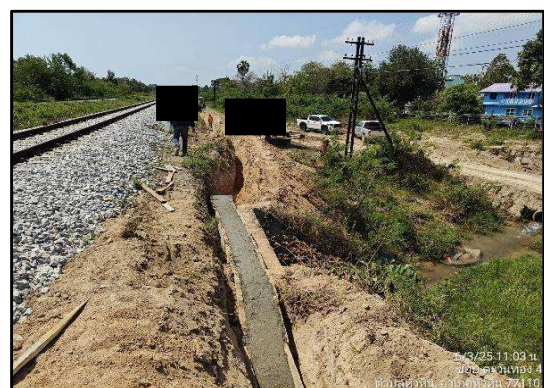
รูปที่ 1-10 งานบ่อ Main Cable Pit และงานก่อสร้าง Cable Trench and Laying Cable บริเวณสถานีห้วยทรายใต้
