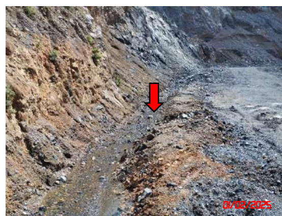
รูปที่ 9 คูระบายน้ำ คันทำนบดิน และบ่อดักตะกอน
