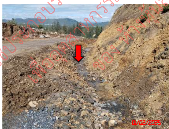
รูปที่ 9 คูระบายน้ำ คันทำนบดิน และบ่อดักตะกอน
