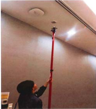
ภาพแสดง การทดสอบและทำความสะอาดอุปกรณ์ Smoke Detector
