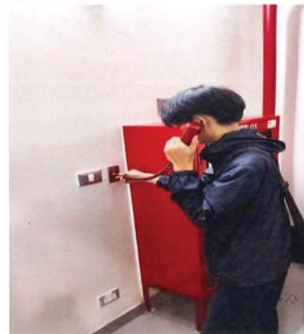
ภาพแสดง การทดสอบอุปกรณ์ Telephone Jack
