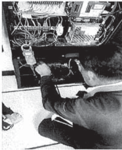
การตรวจสอบการเดินสายสัญญาณ
