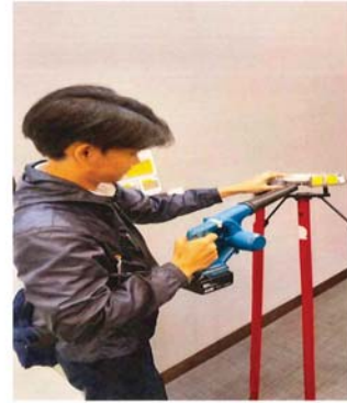
ภาพแสดง การทดสอบและทำความสะอาดอุปกรณ์ Smoke Detector
