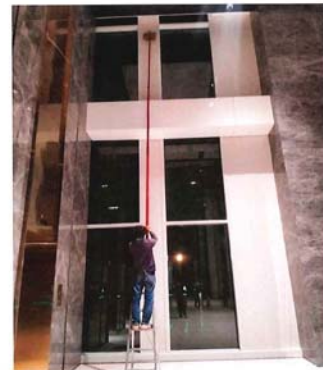
ภาพแสดง การตรวจเช็ค Smoke Beam
