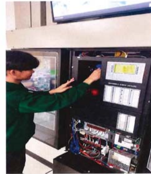
ภาพแสดง การตรวจเช็คและทำการเดินสายต่อ FCP
