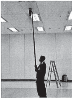
การทำความสะอาดหัวตรวจจับควัน Smoke Detector
