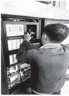
การตรวจสอบการทำงานของแผงควบคุมสัญญาณเตือนภัย
