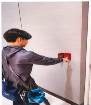
ภาพแสดง การทดสอบอุปกรณ์ Manual Pull Down
