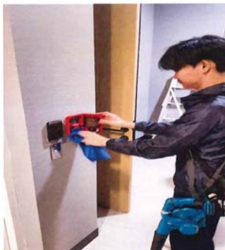
ภาพแสดง การทดสอบและทำความสะอาดอุปกรณ์ Manual Pull Down
