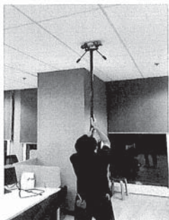
การทำความสะอาดหัวตรวจจับควันและอุณหภูมิ Smoke Detector
