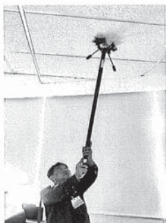
การทำความสะอาดหัวตรวจจับควันและอุณหภูมิ Smoke Detector
