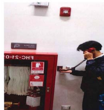
ภาพแสดง การทดสอบอุปกรณ์ Telephone Jack
