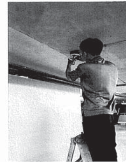
การทำความสะอาดหัวตรวจจับอุณหภูมิ Heat Detector
