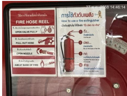
ตู้ FHC และป้ายแสดงวิธีการใช้อุปกรณ์
