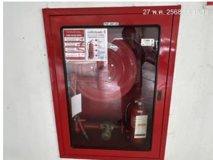
ตู้ FHC และป้ายแสดงวิธีการใช้อุปกรณ์
