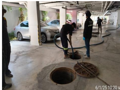
เจ้าหน้าที่สูบล้างปลักไขมันระบบบำบัดน้ำเสีย
