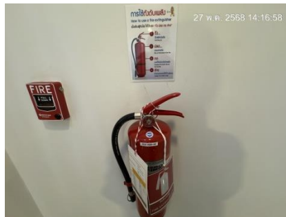
ถังเคมีดับเพลิงและวิธีการใช้อุปกรณ์
