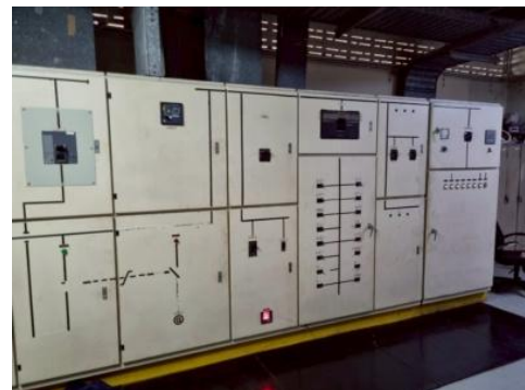
ตู้ควบคุมระบบไฟฟ้า (Power Monitoring) ที่ตู้ MDB
