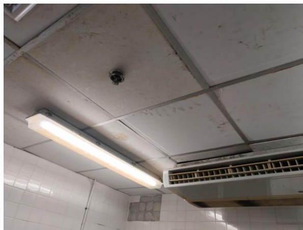
โคมไฟติดแผ่นอลูมิเนียมสะท้อนแสง
