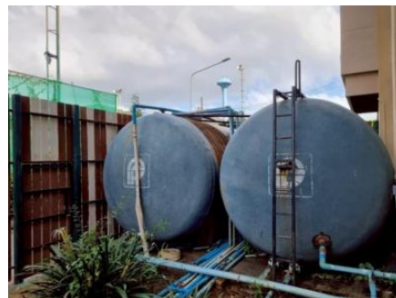
ถังพักน้ำใช้ Ground Water Tank
