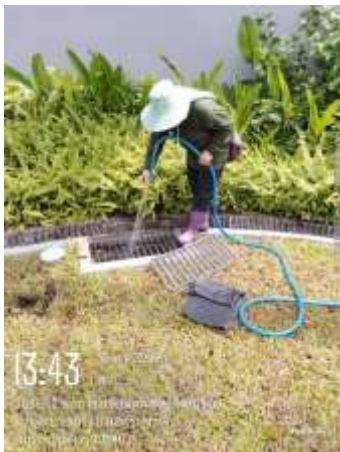
ภาพที่ 2-24 เจ้าหน้าที่ตรวจสอบรางระบายน้ำ
